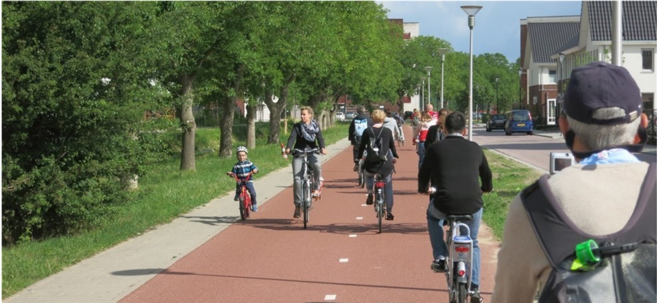
Abbildung 3: Velobahn Arnhem-Nijmegen in den Niederlanden (Quelle: ASTRA, Handbuch Velobahnen). Aufgrund der motorfahrzeugfreien Führung (Radweg) und der hochwertigen Knotengestaltungen wird diese Verbindung von allen Gruppen von Velofahrern als sicher empfunden und genutzt (LTS 0).
