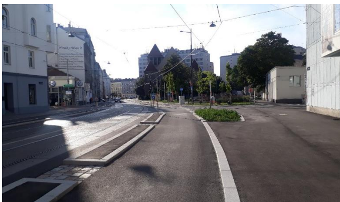
Abb. 9 Radweg mit Schutzstreifen zur Fahrbahn. Quelle: Eigene Aufnahme (AIT)
