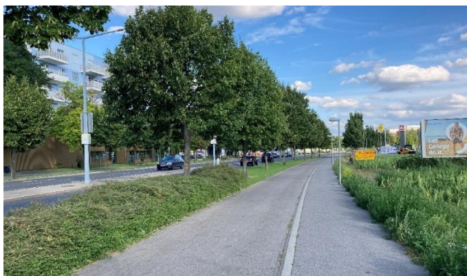
Abb. 7 Radweg mit begleitendem Gehweg an höherrangiger Strasse, beidseitig vorhanden, in beide Richtungen befahrbar. Quelle: Eigene Aufnahme (AIT)
