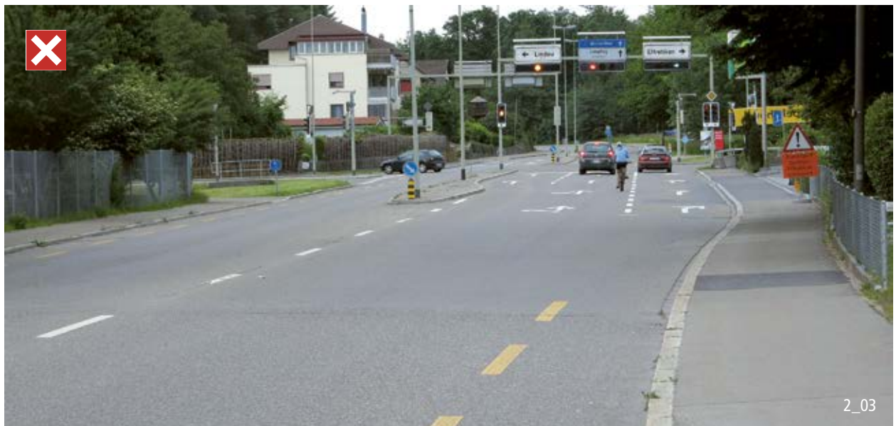
L'infrastructure cyclable s'interrompt avant le carrefour.
