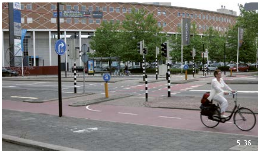
Pistes cyclables avec gués vélo sur toutes les branches du carrefour et SLT (Pays-Bas).
