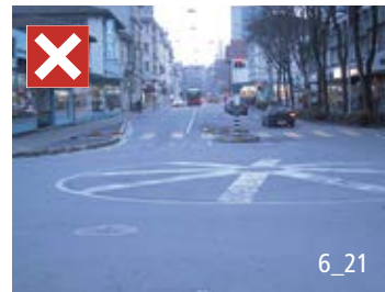
Non cyclo-conforme en raison de l'îlot central franchissable; ne convient pas non plus en tant qu'aménagement provisoire.
