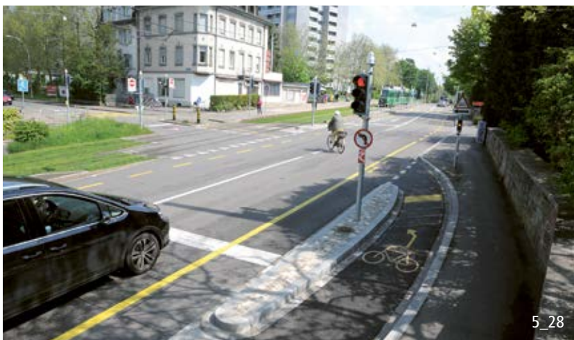
Tourner-à-gauche indirect avant la branche du carrefour (ici réservé aux vélos).
