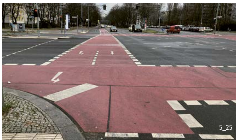
Tourner-à-gauche indirect sur toutes les branches du carrefour (Allemagne).
