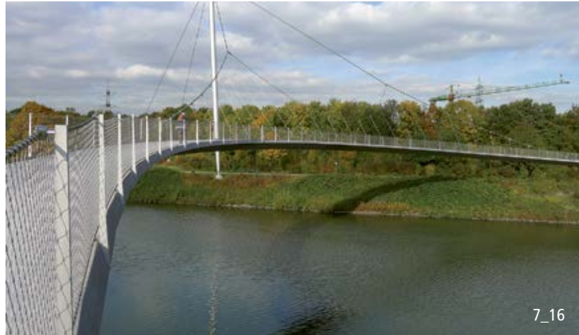
Les rampes avec une faible pente sont les plus confortables (Allemagne).
