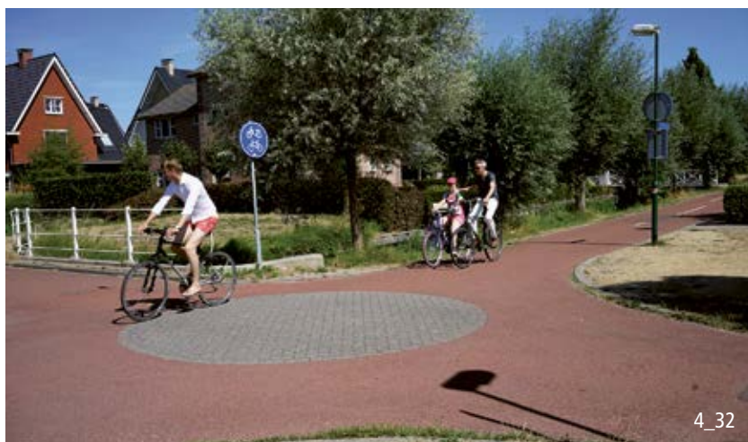
Croisement de pistes cyclables avec priorité de droite. L'îlot central franchissable favorise la reconnaissance du carrefour.
