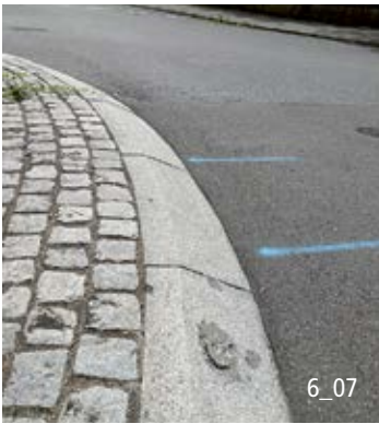
La hauteur de l'anneau central franchissable par rapport à la chaussée doit être de 6 - 8 cm.
