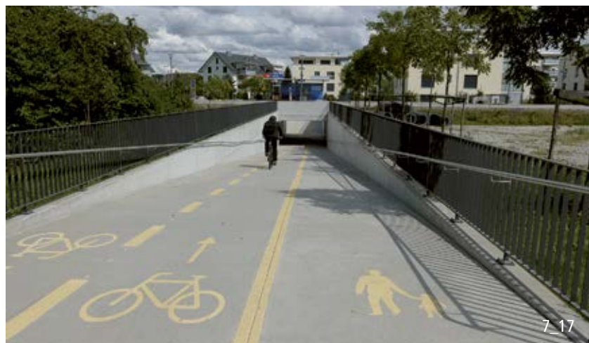
Passage inférieur rectiligne, et donc bien dégagé, avec des rampes confortables.
