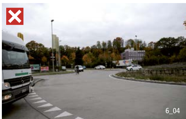
Un anneau de circulation trop large avec un îlot central trop petit et un anneau central pas assez surélevé n'est pas adapté aux vélos.
