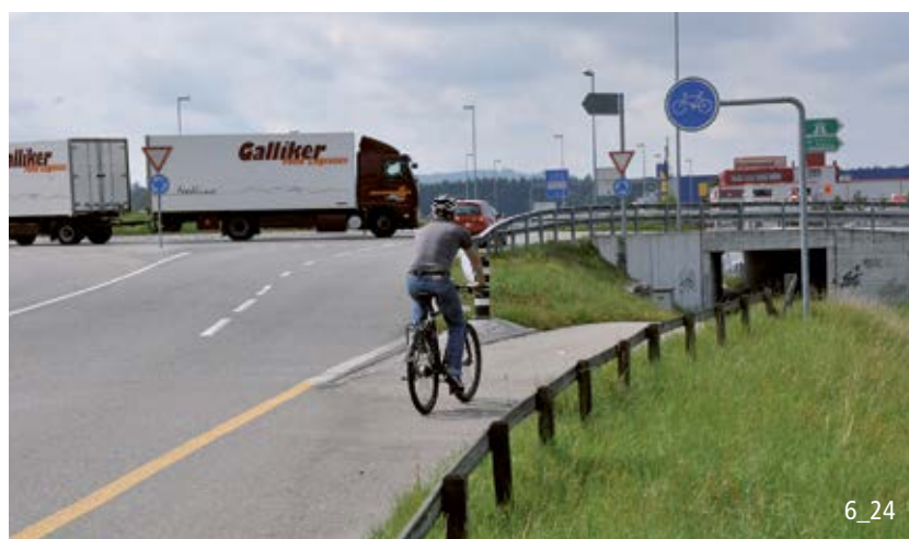
Les cyclistes contournent le giratoire à deux voies à l'aide d'un franchissement dénivelé.
