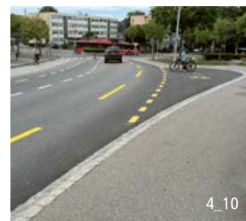
Tourner-à-gauche indirect sans SLT devant une école; les pelotons d'écoliers ont besoin d'une zone d'attente spacieuse.
