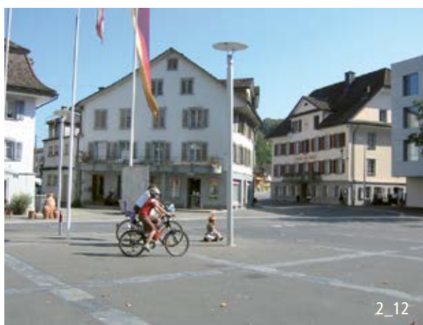
Aménagement multifonctionnel de la place.
