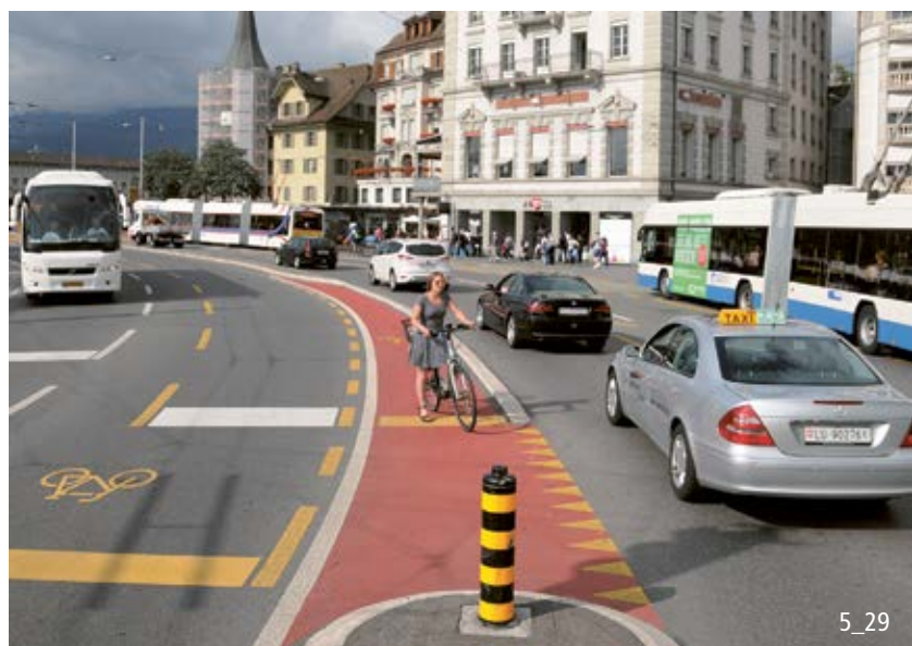
Tourner-à-gauche réservé aux cycles et sécurisé.
