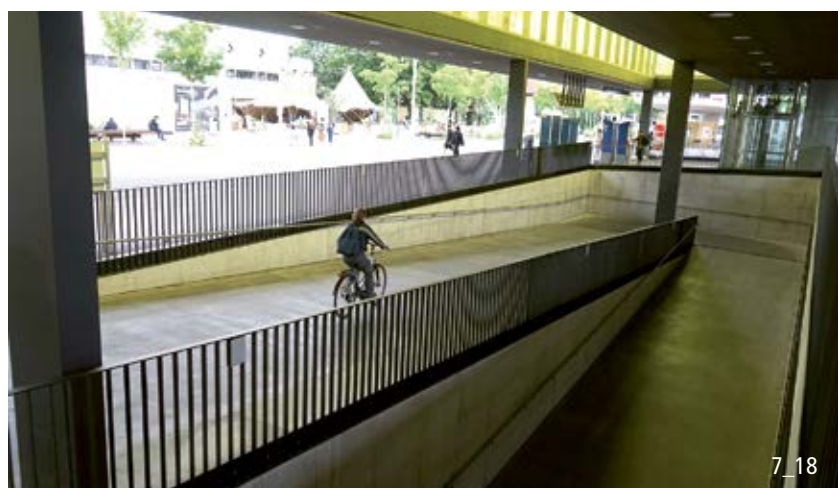
Rampe en courbe pour piétons et cyclistes dans le périmètre de la gare.
