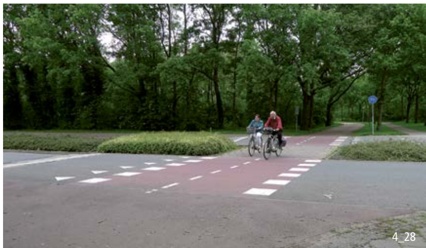
Franchissement prioritaire d'une route principale avec un flot central spacieux (Pays-Bas).
