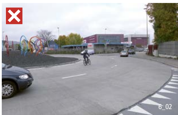
Les giratoires à plusieurs voies à l'anneau et les entrées à deux voies ne sont pas adaptés aux vélos.
