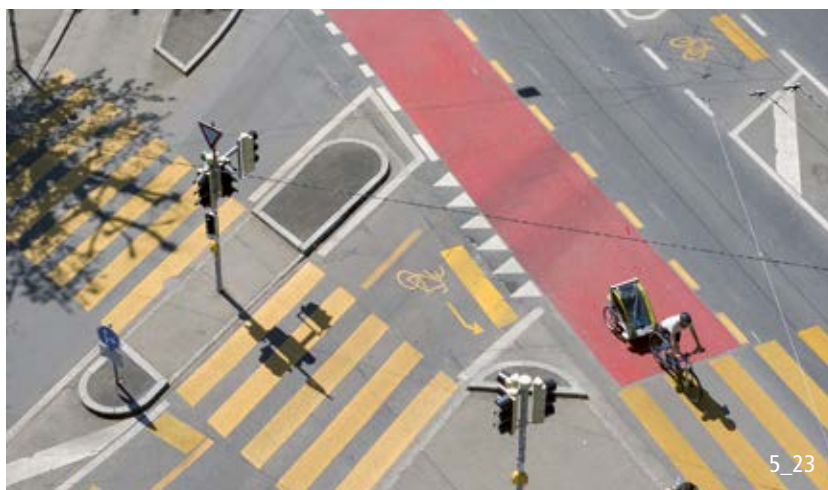
Tourner-à-gauche indirect sur la chaussée.
