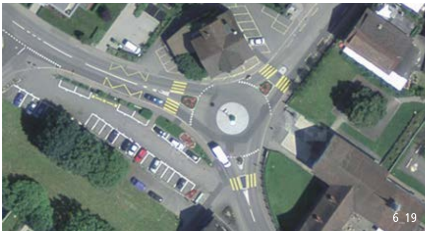
Mini-giratoire d = 22 m, anneau de circulation 6.0 m, îlot central pavé d = 10 m, candélabre sur l'îlot central.
