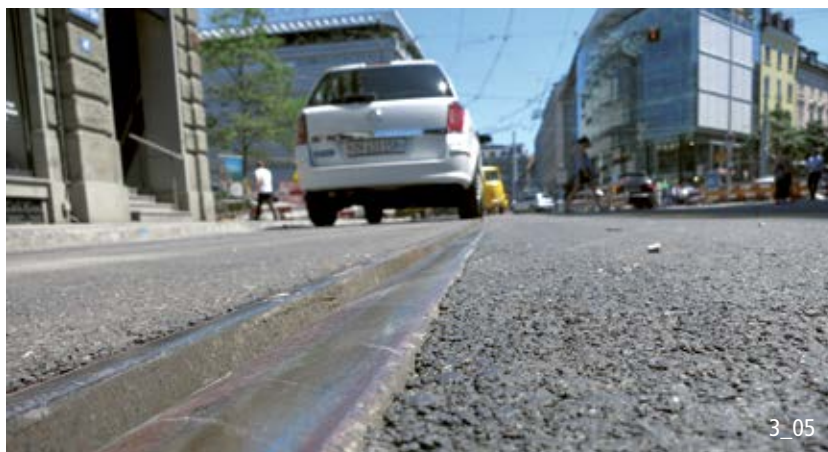
Lors de la pose, il faut veiller à ce que les rails ne dépassent pas de plus de 3 mm.
