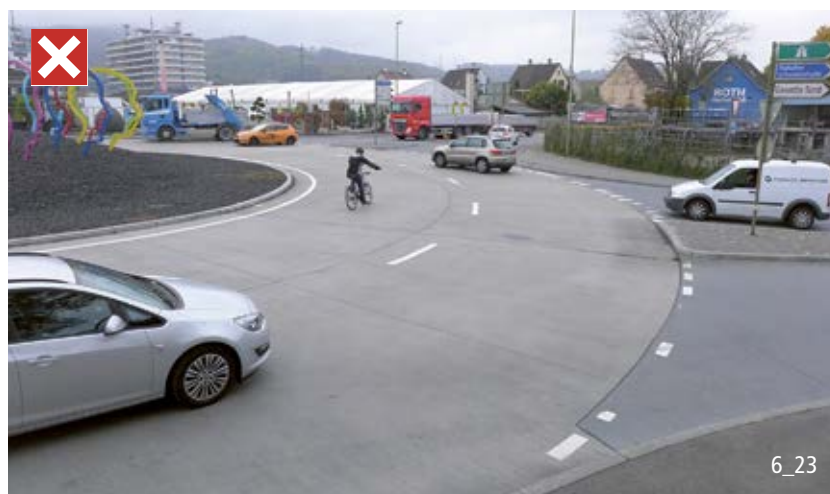
Les giratoires à deux voies à l'anneau ne sont pas cyclo-conformes.
