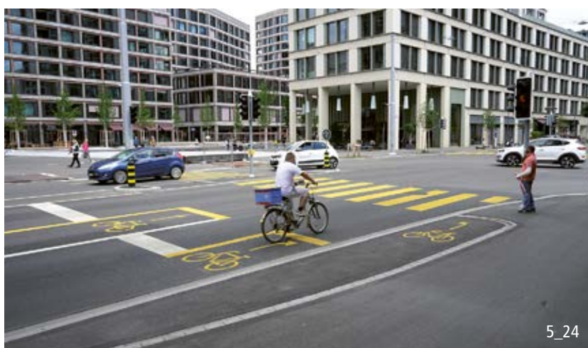
Tourner-à-gauche indirect avec zone d'attente dédiée.
