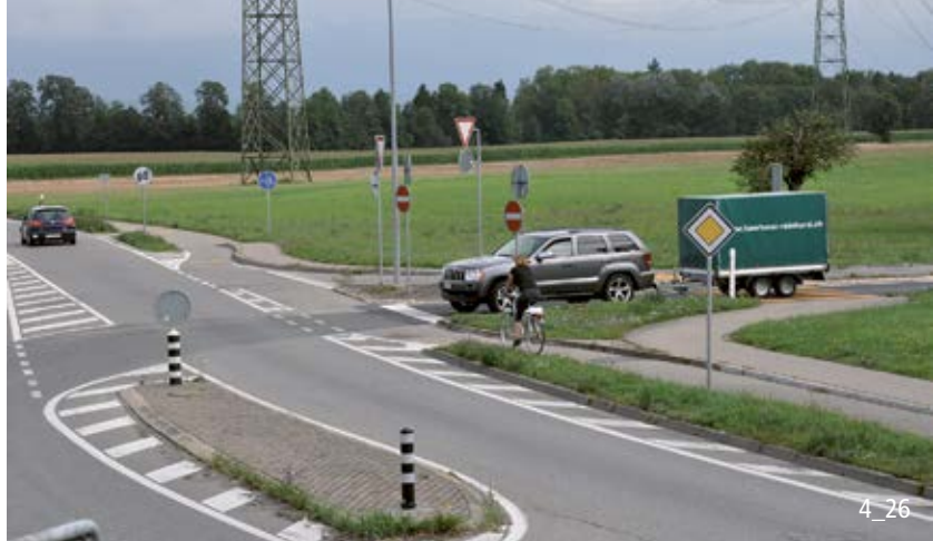
Franchissement prioritaire d'un débouché.
