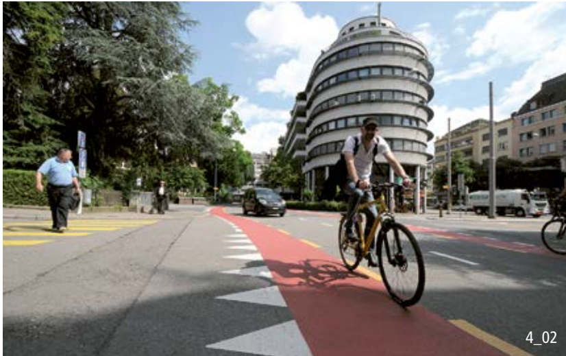
Bande cyclable sur un axe prioritaire avec marquage rouge de la zone de conflit.
