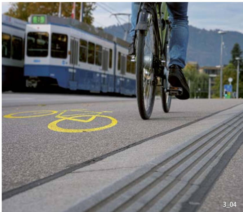
Bordure tactile qui tolère les erreurs pour délimiter la piste cyclable de la surface piétonne. Dans ce cas précis, la hauteur de construction limitée sur le pont implique la réalisation d'une bordure biaise des deux côtés.
