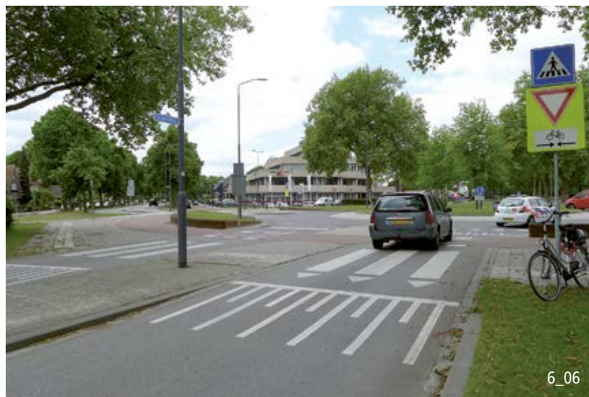
Le décrochement vertical avant le giratoire entraîne une réduction de la vitesse (Pays-Bas).
