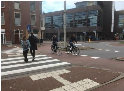
Abbildung 25: Kreisel im Einrichtungsverkehr in dicht bebautem Gebiet
