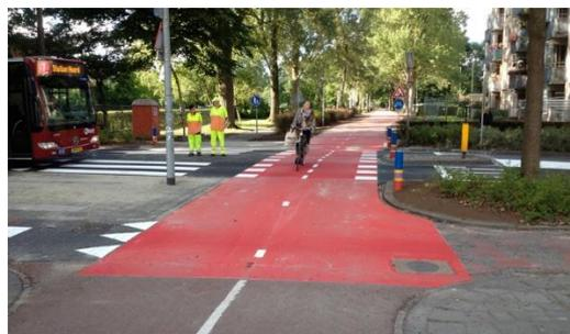
Abbildung 10: Ausgestaltung von Radweg mit Roteinfärbung und Blockmarkierung
