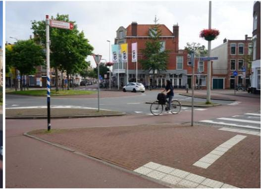
Abbildung 31: Kreisverkehr 22 m Durchmesser mit umlaufendem Radweg
