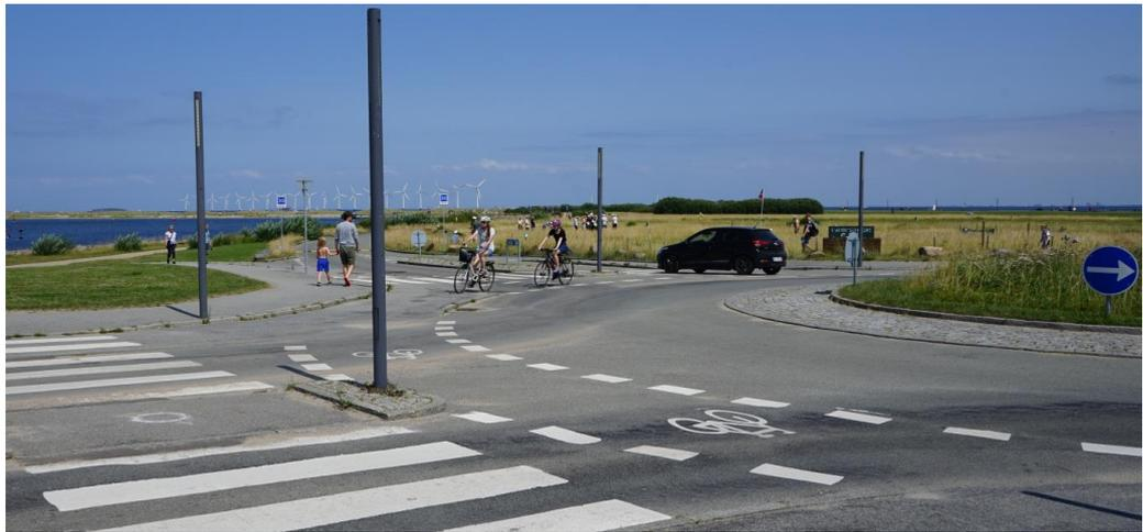
Abbildung 34: Radstreifen auf der Kreiselfahrbahn in Dänemark.
