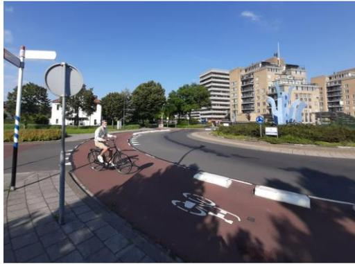
Abbildung 30: Kreisverkehr mit fahrbahnanliegendem Radweg
