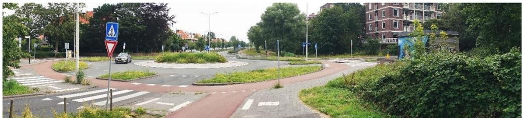
Abbildung 27: Kreisel im Einrichtungsverkehr, Kreiseldurchmesser Fahrbahn 26 m
