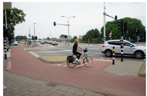
Abbildung 46: Umlaufender Radweg im Zweirichtungsbetrieb
