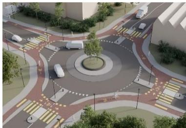
Ein weiterer typischer Anwendungsfall der Velofurt mit Vortritt ist der Kreislauf. Die Veloführung erfolgt getrennt vom motorisierten Verkehr mit umlaufendem Radweg. In den Niederlanden ist diese Führungsform innerorts Standard. Das erreichte Sicherheitsniveau ist hoch. Dementsprechend werden in den Niederlanden Kreislauf mit umlaufenden Radwegen gegenüber Kreuzungen mit oder ohne Lichtsignalanlage (LSA) soweit möglich und sinnvoll bevorzugt.
