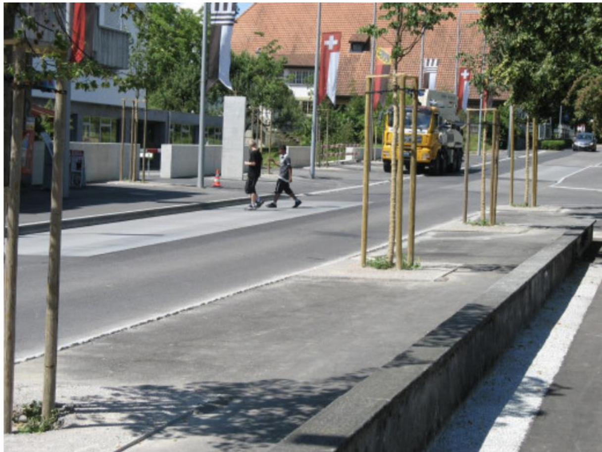
Zone de rencontre sur une route cantonale (Bremgarten bei Bern). Crédit: zonederencontre.ch
