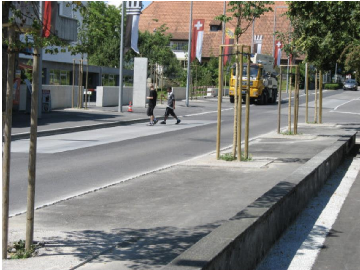
Begegnungszone auf einer Kantonsstrasse (Bremsgarten bei Bern). Bildnachweis: zonederencontre.ch
