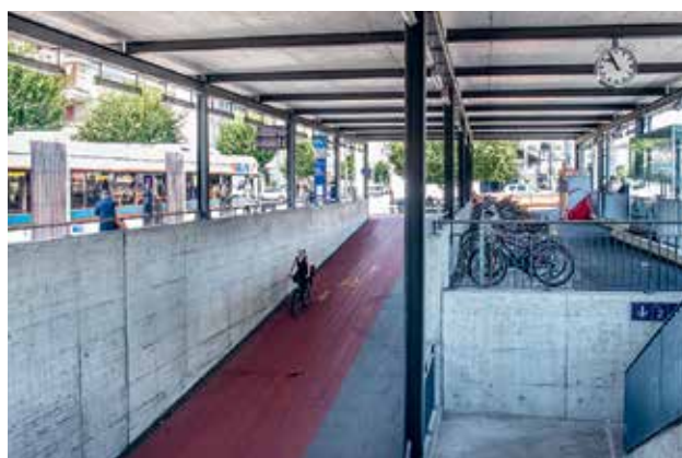
Figure 4: Le passage inférieur pour vélos relie la gare ferroviaire et la gare routière. Photo: Marion Nitsch/ARE
