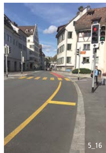
Vert permanent pour les cyclistes allant tout droit; feu rouge uniquement lors de la phase de vert pour les piétons.
