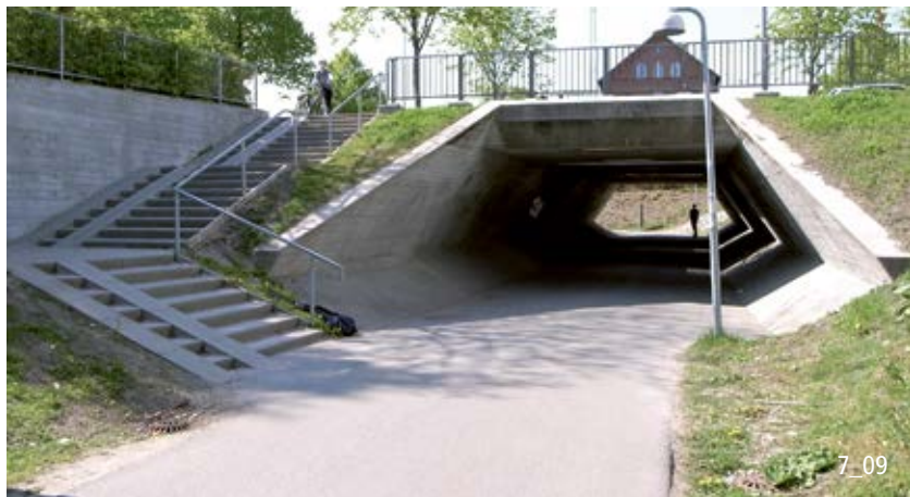
La forme rhomboïdale des passages inférieurs donne une impression d'espace et permet d'utiliser la largeur libre de manière optimale (Danemark).
