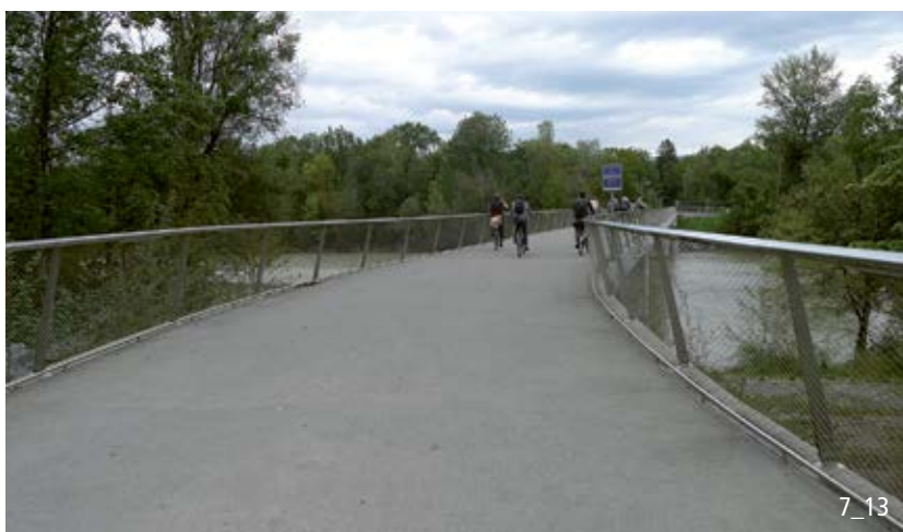
La largeur de 5 m de la passerelle piétons-vélos est adaptée pour une fréquentation moyenne; les croisements et les dépassements se font de manière confortable (Autriche).
