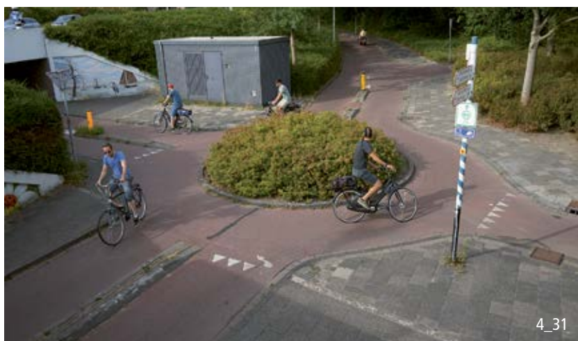
Croisement de pistes cyclables avec giratoire, diamètre extérieur = 10 m, diamètre de l'îlot = 5 m.
