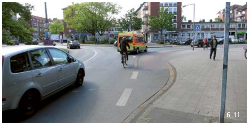
Le bypass vélo protège les cyclistes quittant le giratoire des véhicules qui coupent le virage.
