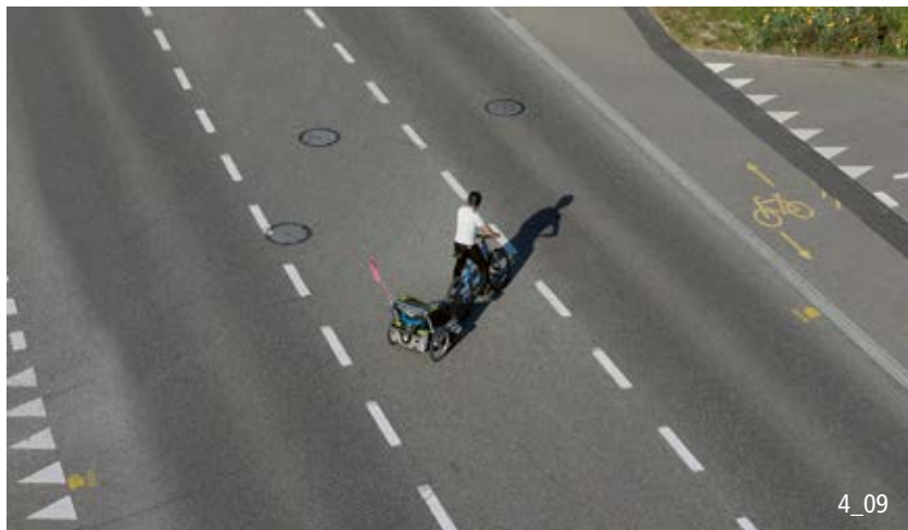
Une largeur \geq 3.50 m améliore grandement la fluidité du déplacement et la sécurité des cyclistes.
