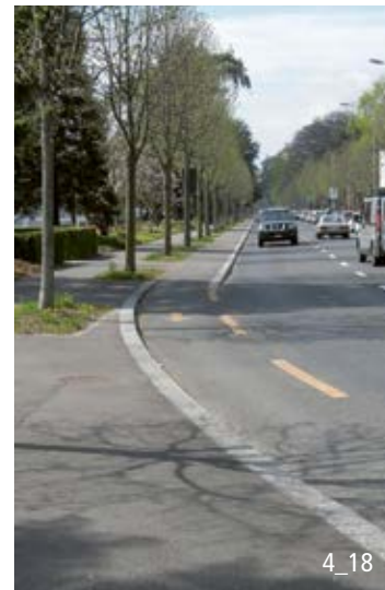
Réinsertion d'une piste cyclable directement accolée à la chaussée.
