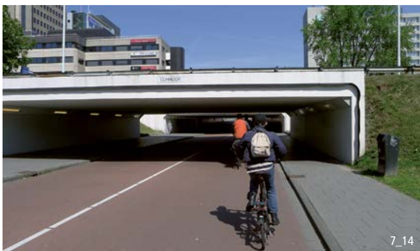
Passage inférieur aux dimensions généreuses pour les piétons et les vélos à proximité d'une gare, conçu pour une fréquentation très élevée (Pays-Bas).
