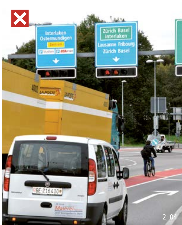
Trop peu de place disponible pour les cycles pour des raisons de capacité.
