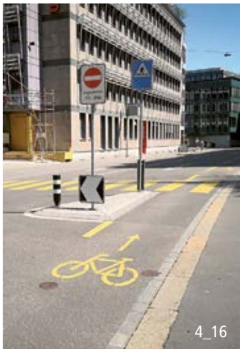
L'îlot de séparation marque l'entrée de la rue à sens unique avec contresens cyclable.
