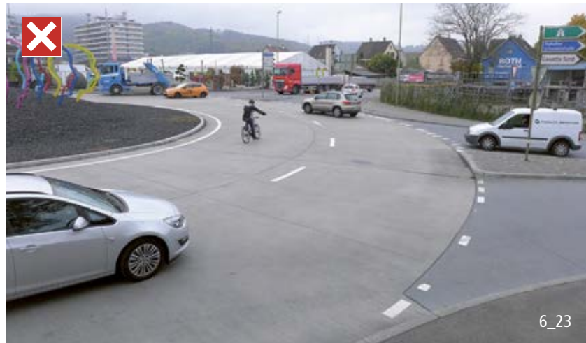
Les giratoires à deux voies à l'anneau ne sont pas cyclo-conformes.
