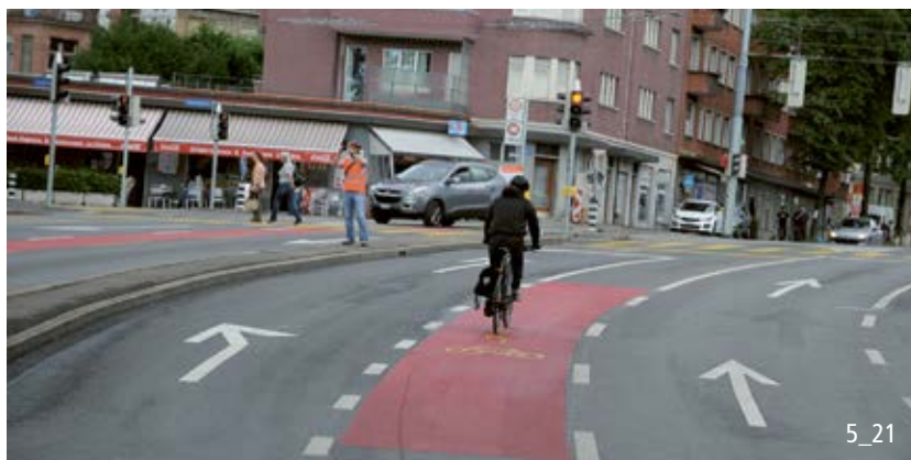
Les bandes cyclables en milieu de chaussée doivent avoir au moins 1.80 m de large, et ne devraient pas dépasser 30 m de long.
