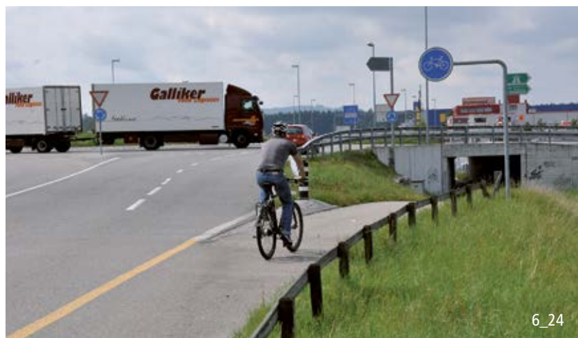
Les cyclistes contournent le giratoire à deux voies à l'aide d'un franchissement dénivelé.
