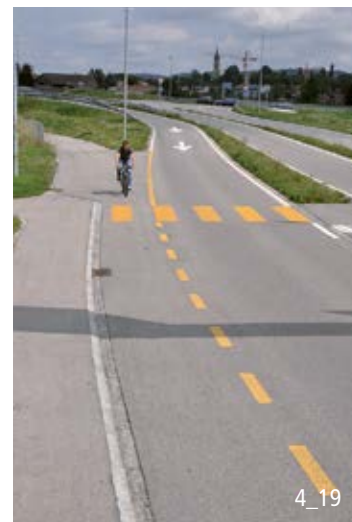
Réinsertion d'une piste cyclable avec bande de séparation.
