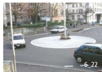
Mini-giratoire avec anneau central causant une déviation et îlot central infranchissable.
