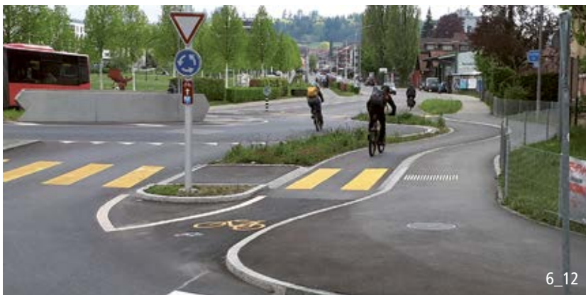
Velobypass in 3-Arm-Kreisel ermöglicht sichere und komfortable Durchfahrt ohne Vortrittsentzug.
