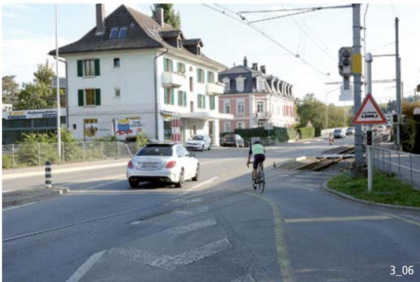
Verbesserung des Querungswinkels abseits des Motorfahrzeugverkehrs.
