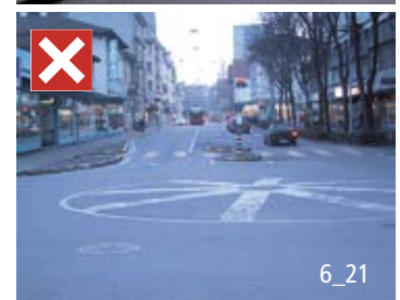
Nicht veloverträglich wegen überfahrbarer Mitte; auch nicht als Provisorium geeignet.
