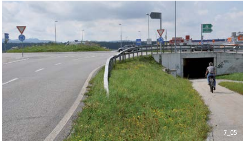
Der Veloverkehr wird mit einer Unterführung niveaufrei um den nicht veloverträglichen, zweistreifigen Kreisell geführt.
