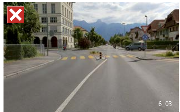
Der Durchschuss erhöht die Geschwindigkeit im Kreisel.
