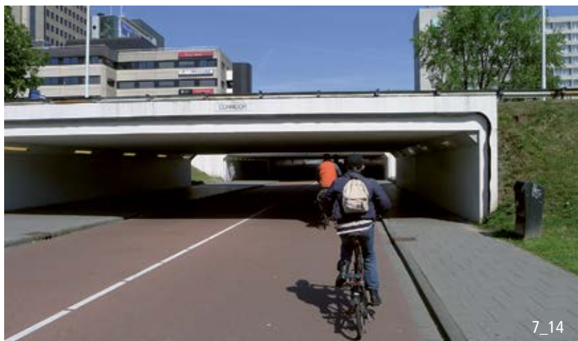
Grosszügig dimensionierte Fuss- und Veloverkehrsunterführung in Bahnhofsnähe für sehr hohe Frequenzen (Niederlande).
