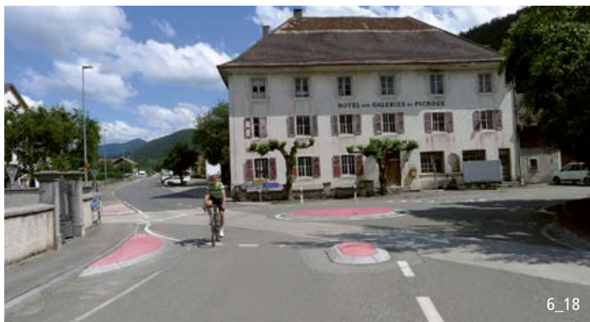
Minikreisel d = 15 m, Kreiselfahrbahn ohne Innenring 5.25 m, Mittelinsel gepflästert d = 4.5 m, Mittelinsel überfahrbar, aber erhöht (Rand = 7.5 cm hoch, Mitte ca. 12 cm hoch); Leitinseln ebenfalls erhöht und farblich hervorgehoben.
