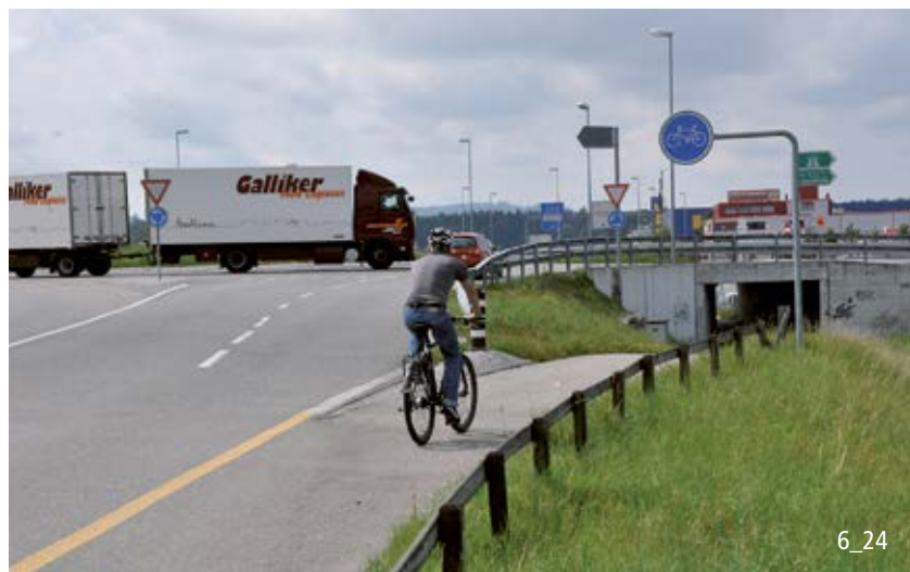
Veloumfahrung des zweistreifigen Kreisels mit niveaufreier Querung.
