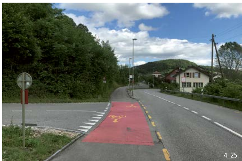
Abb. 442 Vortrittsberechtigige Führung eines Zweirichtungsrادwegs
