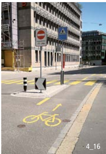
Treninsel als Einfahrt in Einbahnstrasse in Gegenrichtung.
