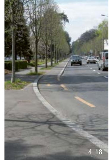
Rückführung eines Radwegs direkt an die Fahrbahn anliegend.
