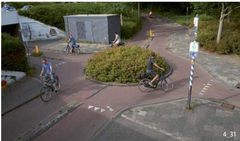
Radwegkreuzung mit Kreisel, Aussendurchmesser = 10 m, Durchmesser Insel = 5 m.
