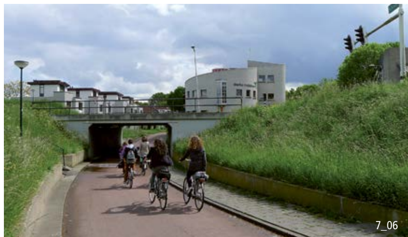
Unterbrechungsfreie Fahrt auf einer Velohauptroute bei der Querung einer städtischen Ringstrasse (Niederlande).
