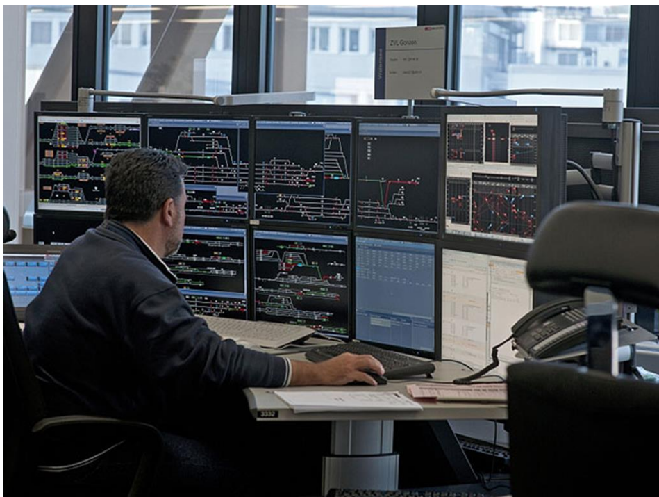
Abbildung 33: Typischer Arbeitsplatz in der SBB Betriebszentrale (BZ)
