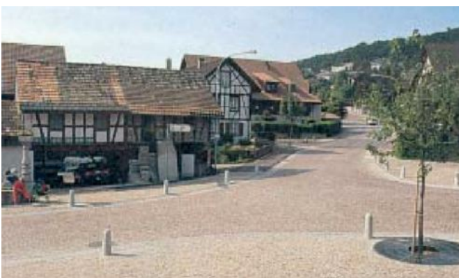
Hoffnungsplatz entièrement pavée avant le 2 e réaménagement de 2006. Source : canton de Zurich
