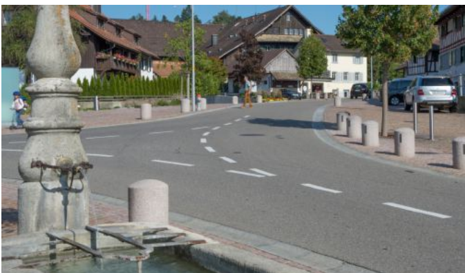
Carrefour Zürcherstrasse/Schlierenstrasse : la surface de la chaussée est réduite au strict nécessaire. Le marquage au sol met en évidence la priorité de droite.
