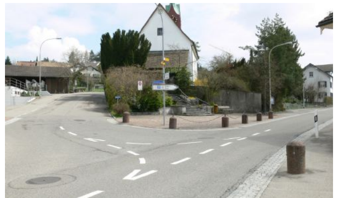
Carrefour Zürcherstrasse/Allmendstrasse avant le 2 e réaménagement de 2006. Source : ewp AG Affoltern
