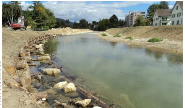
Les caissons en bois sont construits le long des berges et offrent de nombreuses cachettes aux poissons.
