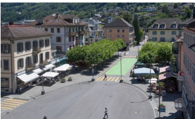
Vue aérienne de la Place Centrale. Aujourd'hui, les pavés ont laissé leur place à un revêtement moins bruyant, mais plus routier. Il a fallu renoncer à l'unité visuelle, mise en avant dans le projet initial, face aux nuisances sonores. Les larges bandes vertes ont comme objectif de réduire la vitesse des véhicules.
