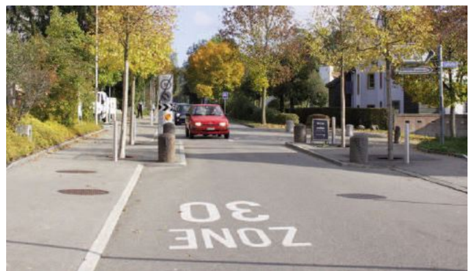
Les rétrécissements aménagés en « portes arborées » compartimentent l'espace et modèrent le trafic.
