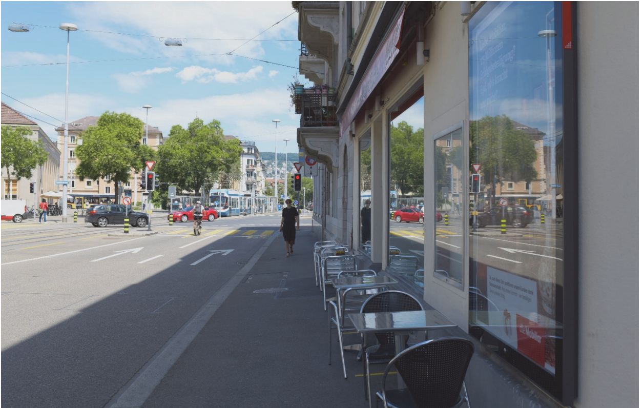
Birmensdorferstrasse (Bedeutung: regional/stadtweit): keine ausreichende lichte Breite, zu geringe Umfeldzuschläge zum Strassencafé und zur Fahrbahn hin
