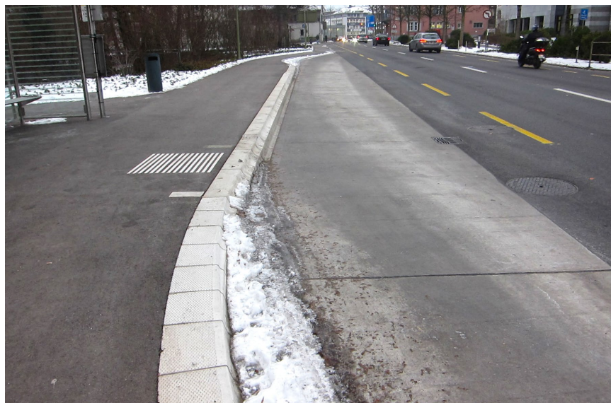
Fig. 27 – Liestal BL : malgré le renforcement du trottoir, qui raccourcit le tronçon d'accès, un arrêt de bus en encoche avec bordure d'accostage à niveau nécessite beaucoup d'espace (photo : Andreas Stäheli)
