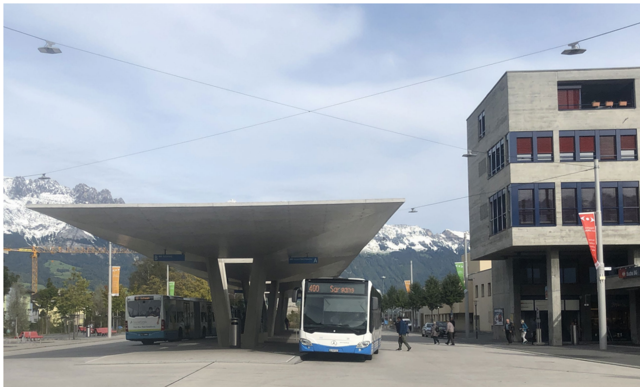
Fig. 1 – Buchs SG: nouvel aménagement de la gare routière à la gare.
