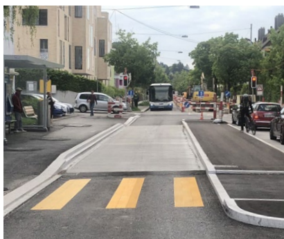
Fig. 10 – Zurich : dans le cadre de l'assainissement de la route, l'arrêt a été réaménagé selon le principe d'accessibilité universelle.
