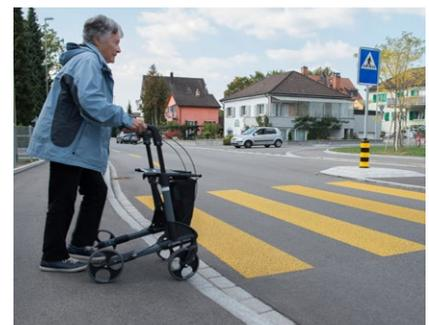
Abb. 24 – Opfikon ZH: Eine Trottoirabsenkung erleichtert behinderten und älteren Personen die Strassenquerung.
