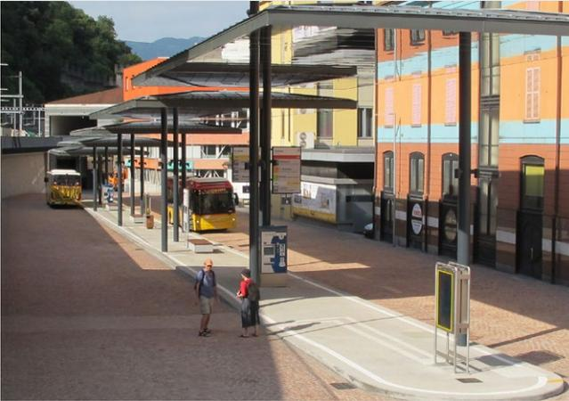
Bellinzona TI: Die Busse werden an beiden Seiten entlang eines Mittelperrons aufgereiht. Die beidseitige Zufahrt ist möglich. Die Minimalbreite beträgt 4.0m, bei frequentierten Anlagen 6.0m. Um den Platz für die Zirkulation frei zu halten, sind Sitzbänke, Billettautomaten und Dachstützen in einer Reihe anzuordnen.
