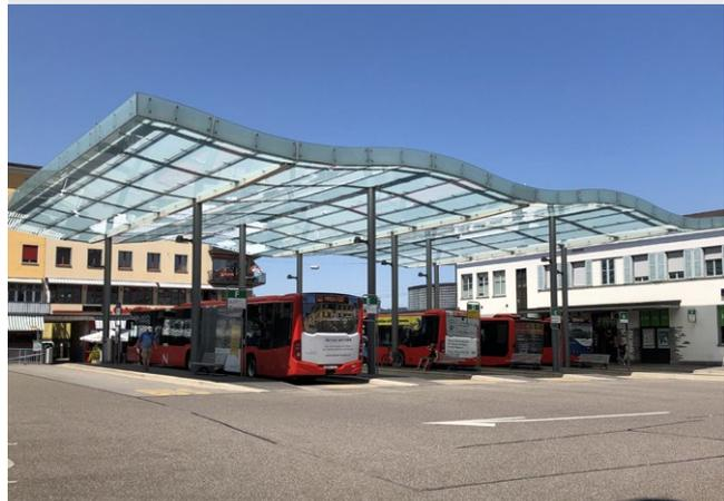
Wädenswil ZH: Jede Haltestelle ist an ein Perron mit orthogonaler oder schräger Aufstellung angebunden. Vorteilhaft ist die gute Zugänglichkeit der Haltestellen für die Busse, nachteilig das «Auf und Ab» bei Umsteigevorgängen für die ÖV-Benutzenden. Schrägaufstellungen lassen sich ortsbaulich schlecht in das Umfeld integrieren, sind aber fahrgeometrisch vorteilhaft.
