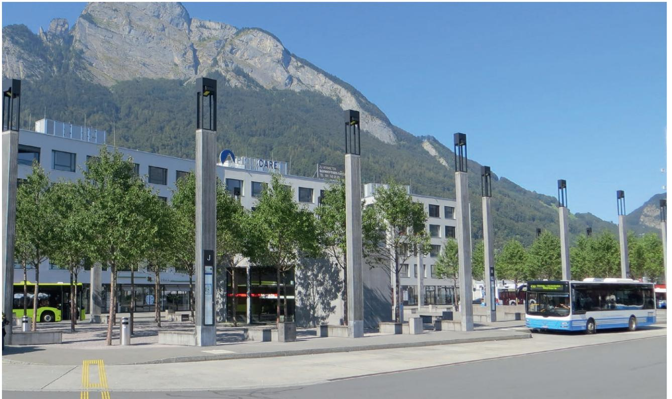
Abb. 31 – Sargans SG: Die Haltestellen sind rund um den Platz angelegt. Die unabhängige Zu- und Wegfahrt der Busse ist dank der verzahnten Anlegekanten und der grosszügigen Erschliessungsfläche möglich. Dies erlaubt einen flexiblen Betrieb.
