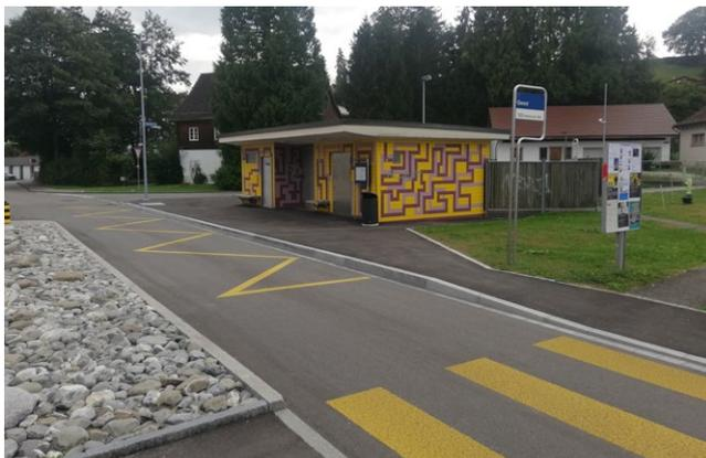
Abb. 15 – Wädenswil ZH: An der Fahrbahnhaltestelle ist die Querung mittels Fussgängerstreifen und Mittelinsel gesichert.
