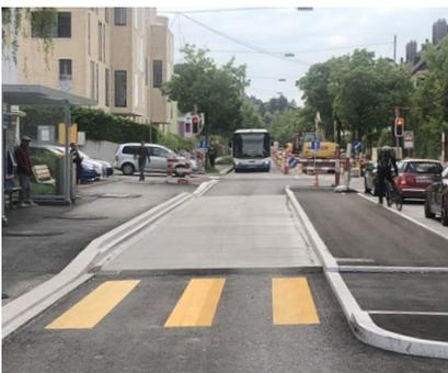
Abb. 10 – Zürich: Im Zuge der Strassensanierung wird die Bushaltestelle hindernisfrei gestaltet.
