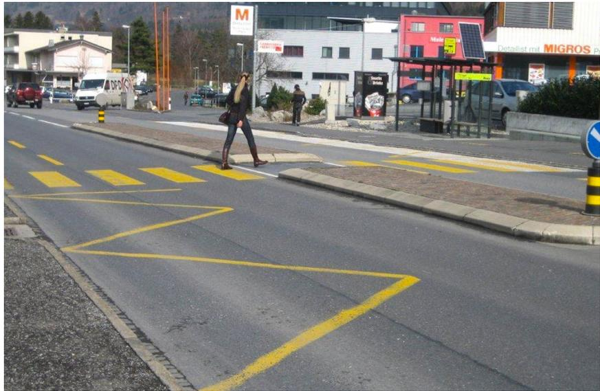
Abb. 27 – Balzers FL: Versetzt angeordnete Fahrbahnhaltestelle mit Mittelinsel
