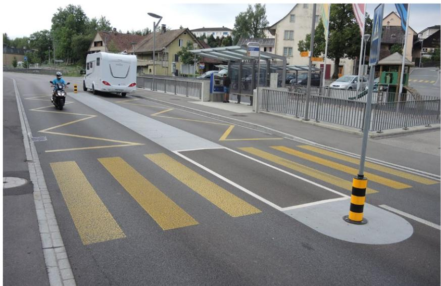
Abb. 25 – Niederlenz AG: Mittelinsel ermöglicht das sichere Queren der Ortsdurchfahrt.
