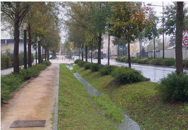
Figura 62 Fossato a Sathonay: «infiltrazione tradizionale»
