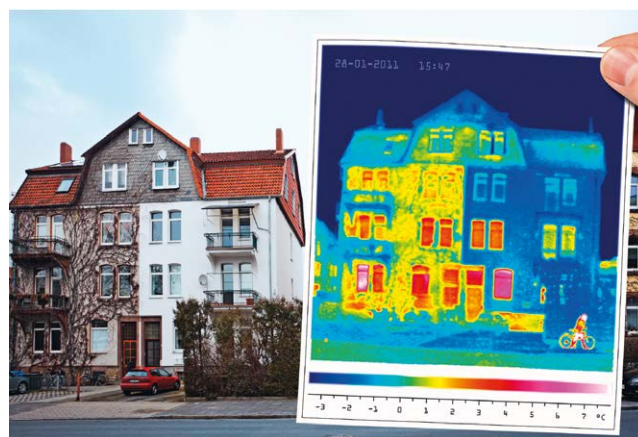
Figura 79 Bilancio termico: facciata risanata (a destra) e non risanata
