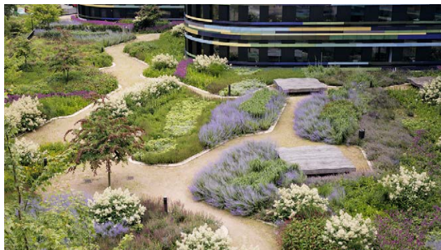
Fig. 70: Vegetalizzazione intensiva dei tetti sopra il garage dell'Ufficio dell'ambiente e dell'energia di Amburgo
