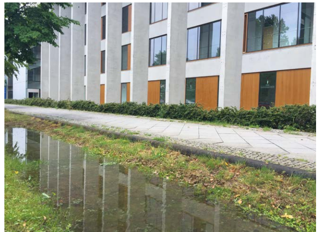
Figura 64 Ritenzione e infiltrazione lenta a Adlershof
