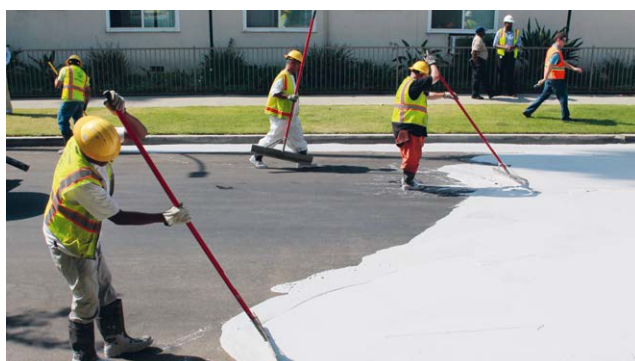
Fig. 82: Riduzione della canicola grazie alla posa di un fondo stradale riflettente: progetto pilota «Cool pavement», Los Angeles
