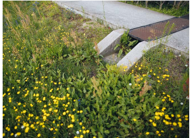
Figura 63 Infiltrazione dell'acqua piovana accanto alla strada a Adlershof, Berlino
