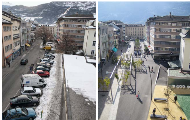
Fig. 83: Progetto pilota ACCLIMATASION a Sion Deimpermeabilizzazione e allestimento di superfici ottimizzate contro la canicola: Place des Remparts prima e dopo la ristrutturazione.
