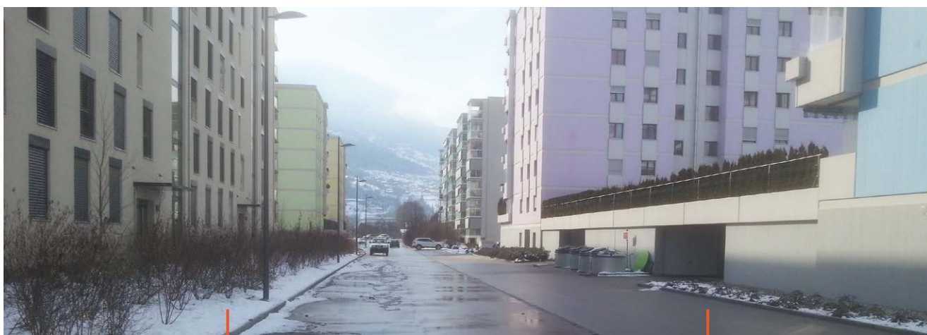
Fig. 17 : Avenue du Bietschhorn à Sion : mise en œuvre directe
