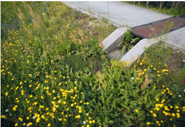
Figure 63 Infiltration des eaux de pluie à côté du chemin pour piétons et de la route à Berlin-Adlershof
