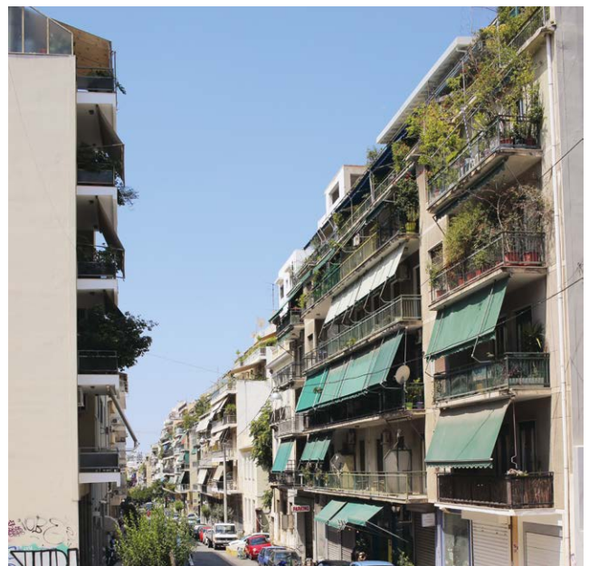
Figure 78 Protection thermique sur des balcons à Athènes
