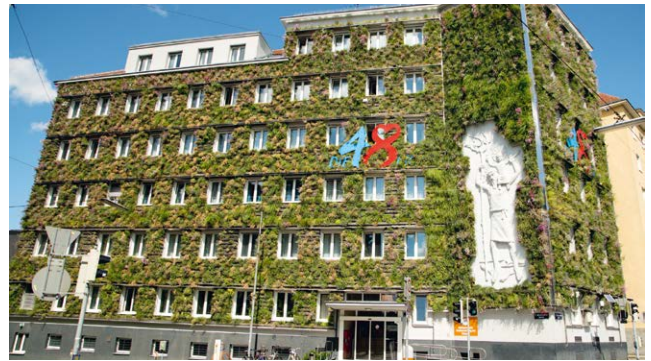
Fig. 73 : Façade végétalisée du «48er-Gebäude» à Vienne
