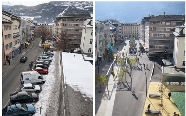
Fig. 83 : Projet pilote ACCLIMATASION à Sion Désimperméabilisation et conception superficielle adaptée au climat – l'Espace des Remparts avant et après la transformation.
