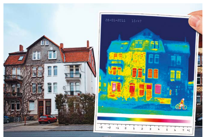
Wärmebilanz: sanierte (rechts) und nicht sanierte Fassade
