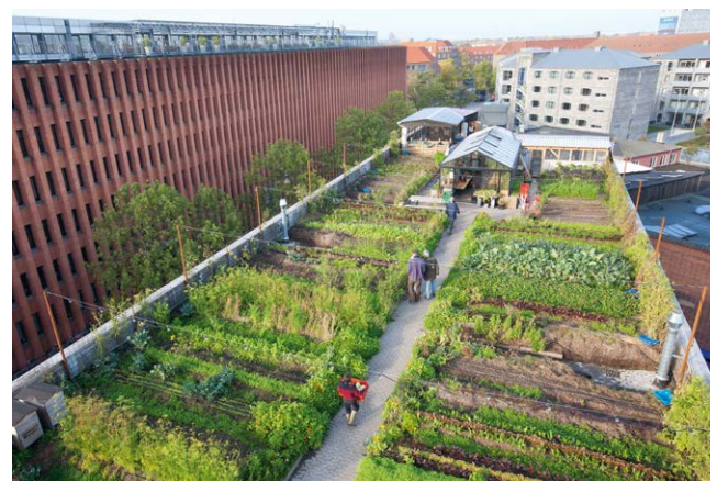
Abbildung 35 Klimawirksame Mehrfachnutzung – Dachfarm ØsterBRO
