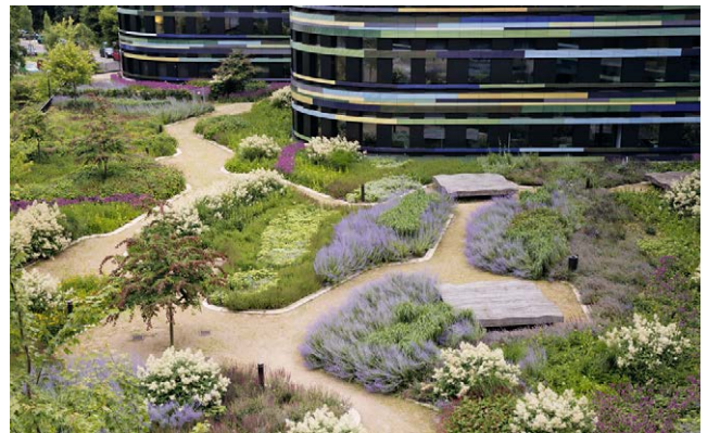
Abbildung 70 Intensive Dachbegrünung über der Tiefgarage der Behörde für Umwelt und Energie von Hamburg
