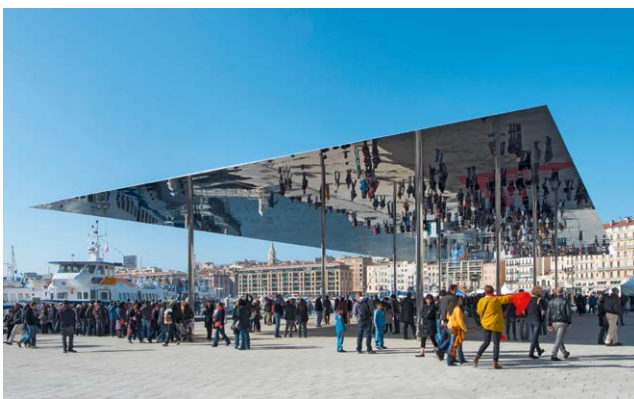
Abbildung 86 L'Ombrière in Marseille
