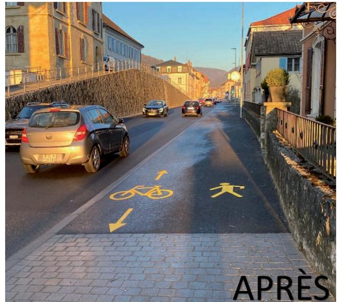
Abb. 4: Gemeinsame Führung des Fuss- und Veloverkehrs auf dem Trottoir, Verschmälerung der Fahrbahn (H10 in Travers)
