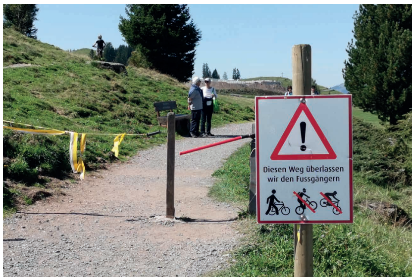
Mesure de construction en situation de séparation accompagnée du panneau d'information correspondant.
