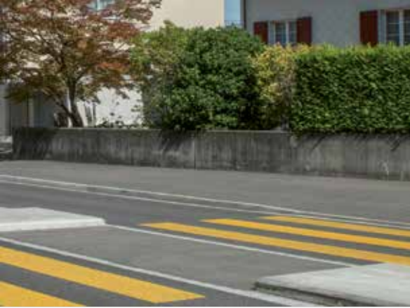
Das Trottoir mit hohem Randabschluss ist im Bereich des Fußgängerstreifens auf 3 cm senkrecht abgesenkt.
