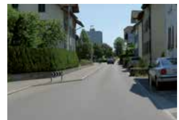
Lange einseitige Einengung aufgrund der räumlichen Situation.
