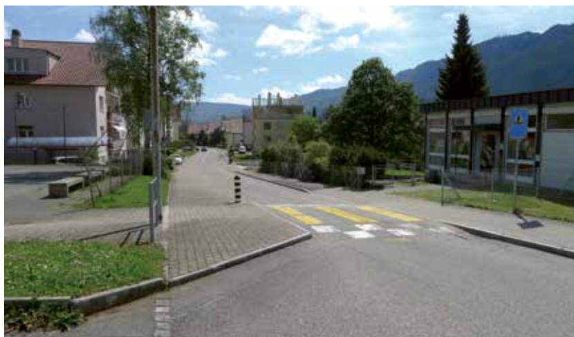
Einseitige Einengung vor Kindergarten ergänzt mit vertikalem Versatz.
