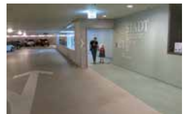
Vom Fahrverkehr geschützter Fussgängerbereich.
