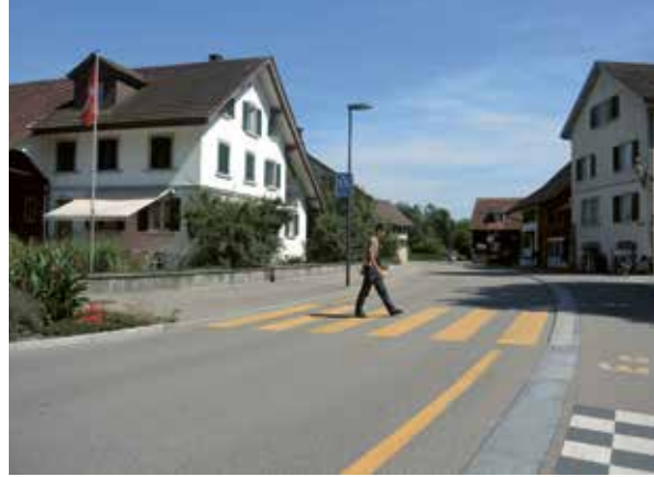
Fussgängerstreifen ohne Mittelinsel auf schwach frequentierter Strasse.
