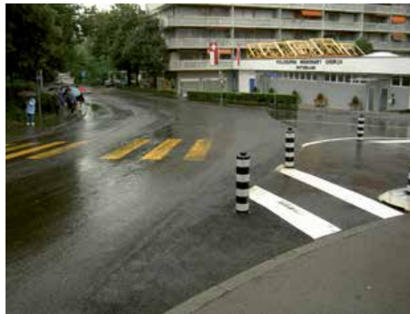
Unklare Verkehrsführung, schlechte Sicht, fehlende Abgrenzung von Trottoir und Fahrbereich.
