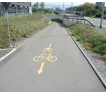
Gemeinsame Führung Fuss- und Veloverkehr vor Unterführung.
