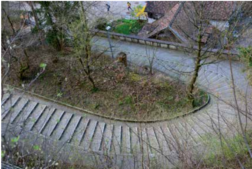
Kombinierte Rampen- und Treppenanlage.
