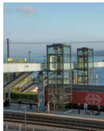
Eine Überführung erschliesst die Perrons mit Lift, verbindet Dorfteile und erleichtert den Zugang zum See.
