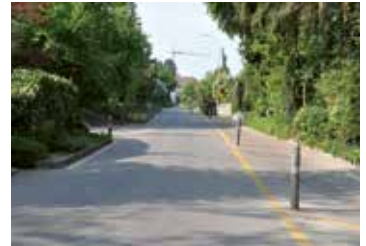
Längsstreifen für Fussgänger mit Pollern geschützt.
