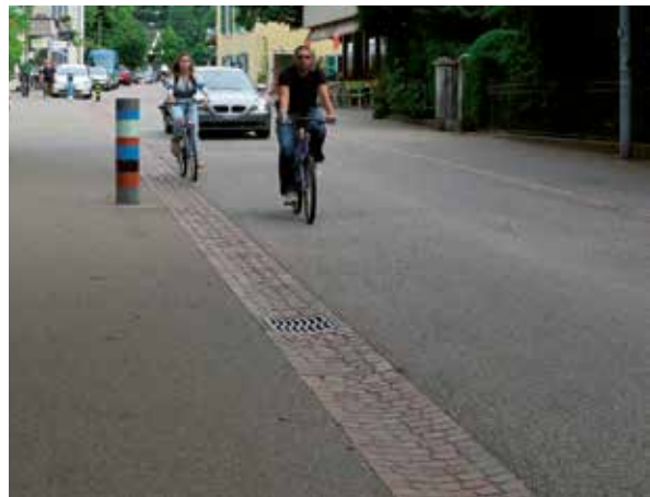
Weiche Trennung mit Wasserschale ist nur bei geringen Frequenzen des motorisierten Verkehrs einzusetzen.
