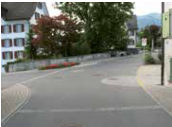
Die halbrunde Pflästerung weist auf einen einmündenden Fussweg und die Querungssituation hin.
