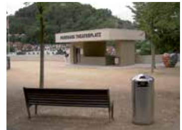
Gut auffindbare und sorgfältig auf die Umgebung abgestimmte Parkhaus-Kleinbaute.
