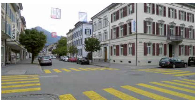
Deux exemples de passages piétons reculés ; en haut, avant une rue prioritaire, en bas à un carrefour à priorité de droite.
