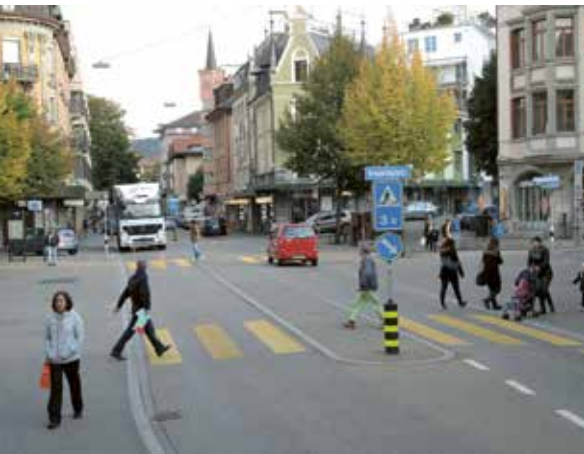
Les îlots centraux réduisent la distance à traverser et permettent de le faire en deux étapes.
