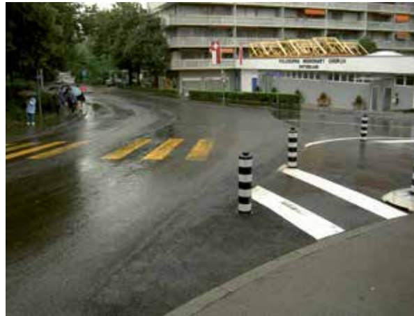
Situation peu claire, mauvaise visibilité, absence de délimitation entre le trottoir et la chaussée.
