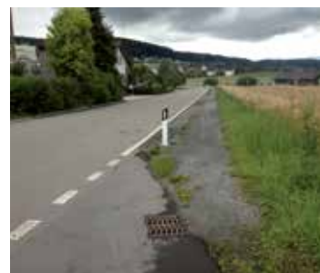
Accotement étroit à la limite de la localité comme mesure immédiate de sécurisation du chemin de l'école.
