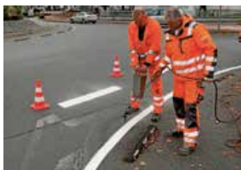
Les mesures mises en œuvre dans le cadre de l'entretien courant et les mesures de petite envergure sont peu coûteuses.
