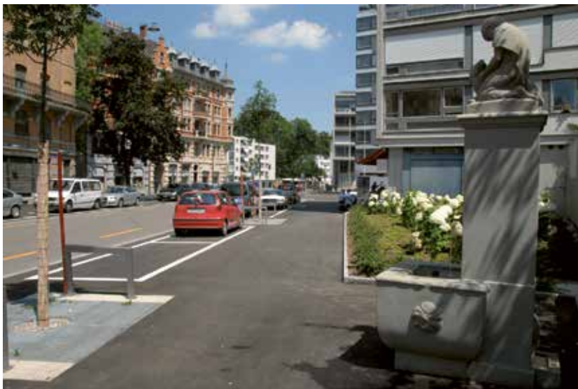
Lors du réaménagement de la rue, la chaussée a été rétrécie et le stationnement placé sur le trottoir.
