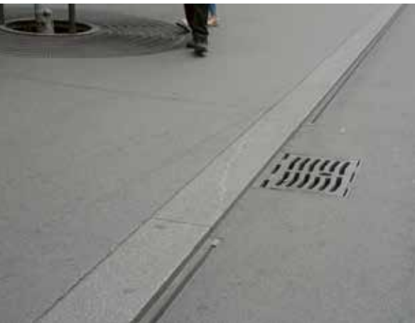
Bordure basse (3 cm verticale) et caniveau à fente pour l'évacuation des eaux.
