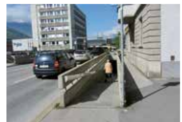
Absence de traversée à niveau.
