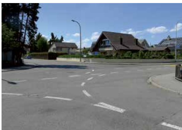
Espace routier surdimensionné dans une rue de quartier.
