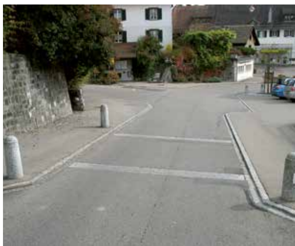
En cas de bordures basses, les potelets peuvent être installés comme mesure complémentaire pour sécuriser la traversée.
