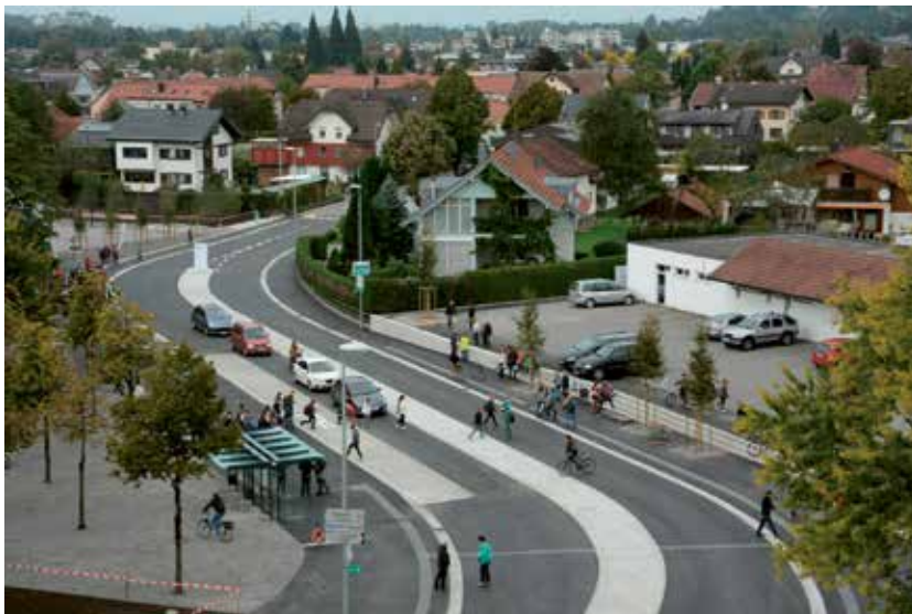
Bande polyvalente au milieu de la chaussée.
