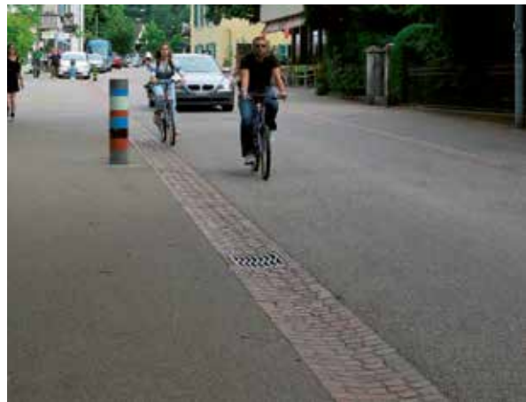
Séparation douce entre l'espace piéton et la chaussée avec une rigole d'écoulement, adaptée uniquement à des charges de trafic faibles
