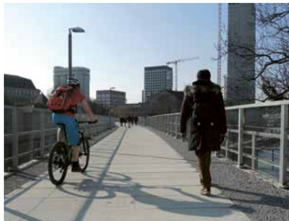
Surface partagée piétons-vélos sur une passerelle en localité.
