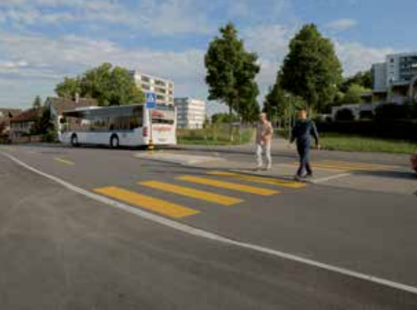
Passage piéton aménagé sur la ligne de désir des piétons.
