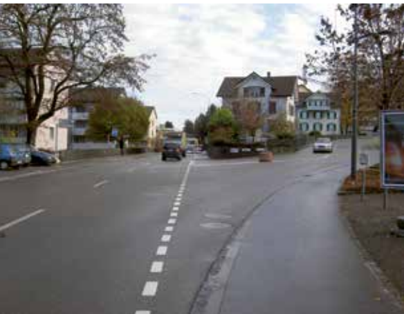
La distance à franchir est trop grande et la vitesse des véhicules motorisés trop élevée en raison de la surface de circulation et du rayon de courbure du virage surdimensionnés.
