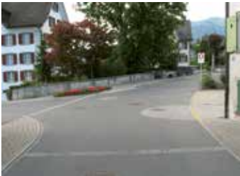
Le pavage en demi-cercle signale le débouché d'un chemin piéton et met en évidence la présence de la traversée.
