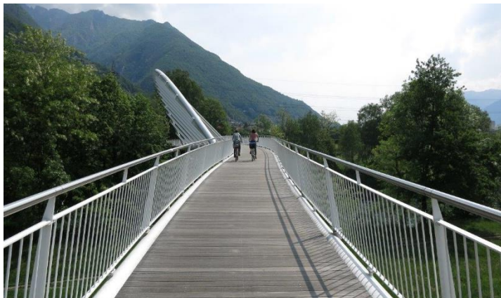
Ponte ciclopedonale di Monte Carasso – Bellinzona (TI)
