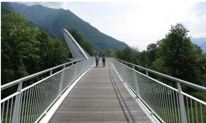
Pont réservé à la mobilité piétonne et au trafic cycliste entre Monte Carasso et Bellinzone (TI)
