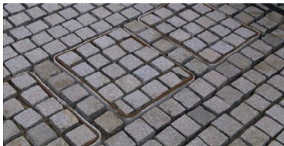
Abbildung 7: Abdeckung über den Plattensensoren im Pflasterbelag.
