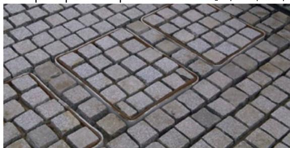
Figure 7 Couverture solide amovible installée dans un sol pavé.
