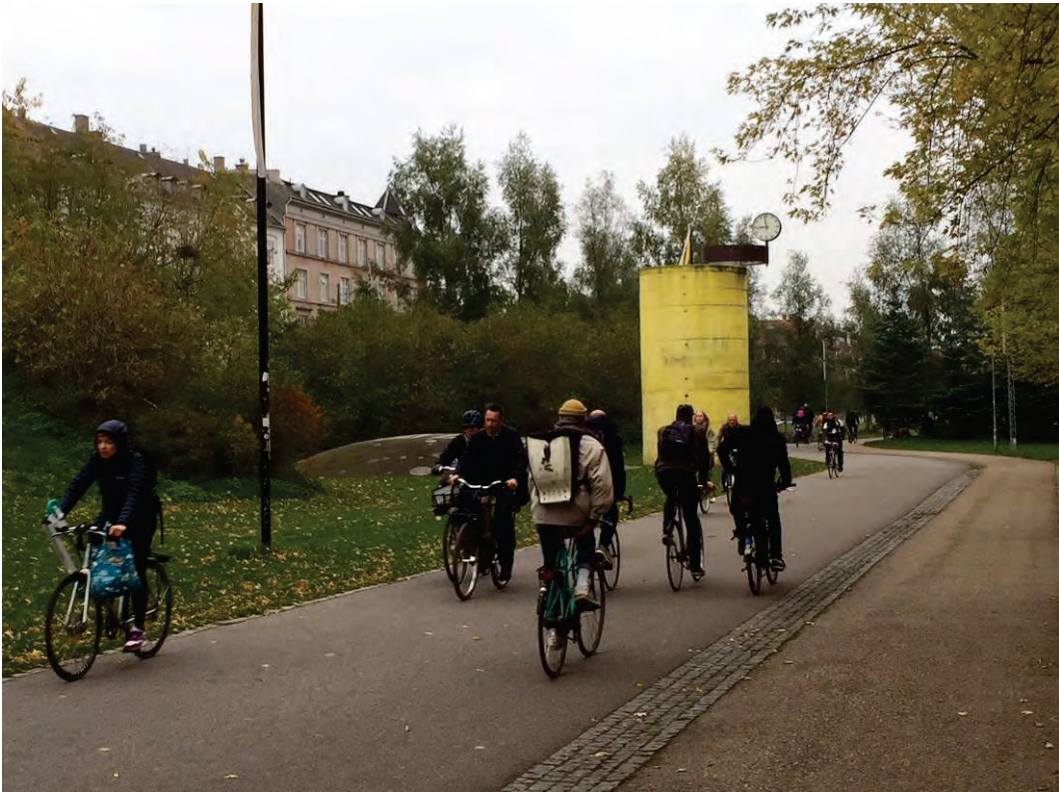
Abb. 7 Begegnungsfall von fünf Velofahrenden auf einem 4 m breiten Zweirichtungsradweg in Kopenhagen (DK). Trotz sehr hohem DWV wird eine hohe Verkehrsqualität erreicht; Foto Andreas Røhl, Gehl Architects
