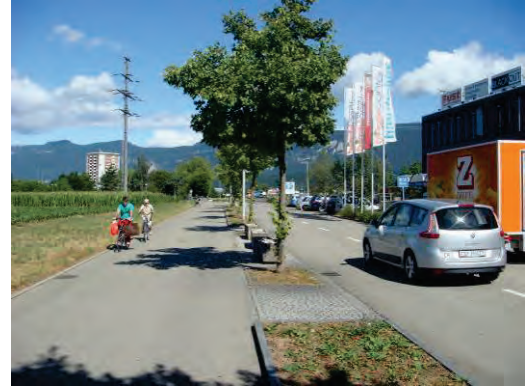
Abb. 75: A2, Waldeggstrasse, Gemeinsamer Rad- und Fussweg, Zuchwil
