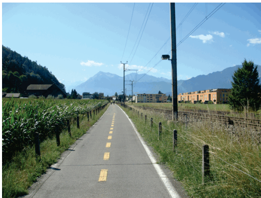
Abb. 45: Zweirichtungsweg Heimberg höhe Grabehüsibach*
