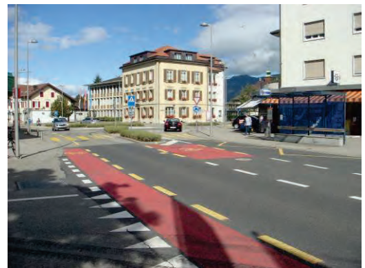
Abb. 79: * Knoten Haupt- / Brunnmattstrasse, Zuchwil
