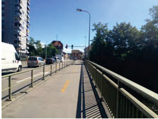
Abb. 74: * Emmebrücke, Gemeinsamer Rad- und Fussweg, Derendingen
