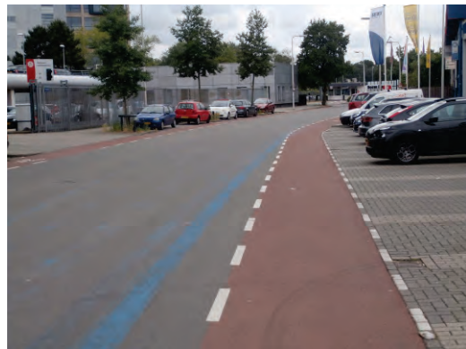
Abb. 29 Veloroute klar getrennt von parkierenden Autos
