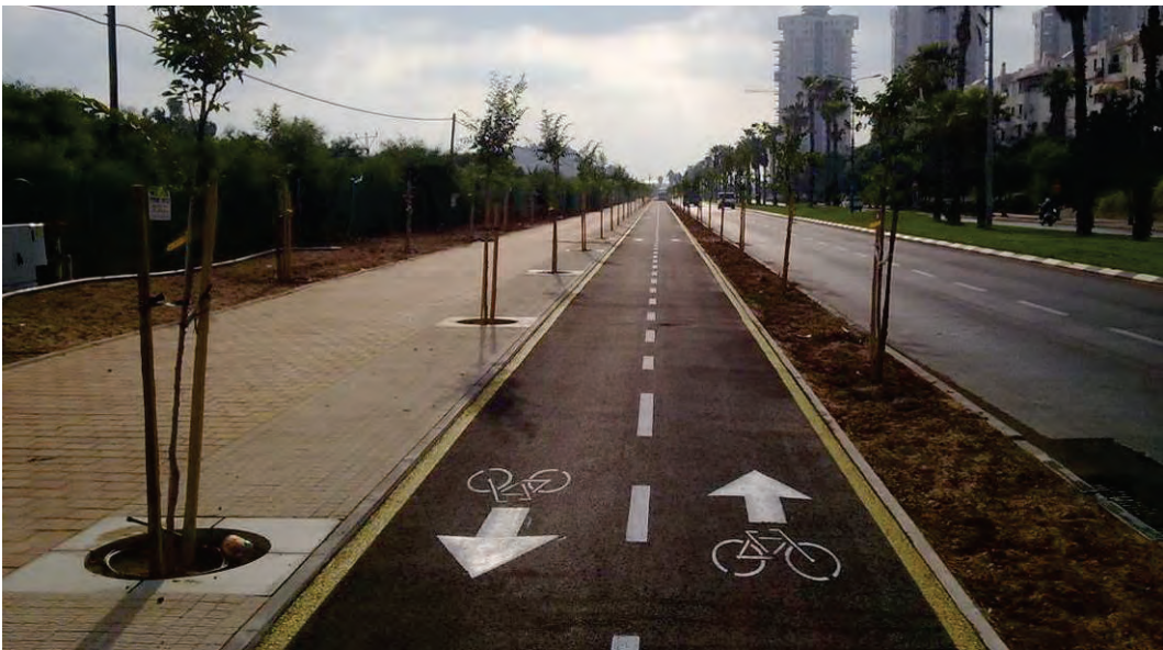
Abb. 66 Grünstreifen als Trennelement zwischen dem Veloverkehr und dem MIV (ISR); Foto: Wikipedia
