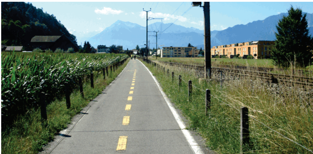
Abb. 10 Eigenständig geführter Zweirichtungsradweg (3 m breit) im Agglomerationsgürtel auf der Veloverbindung Heimberg – Thun (CH)
