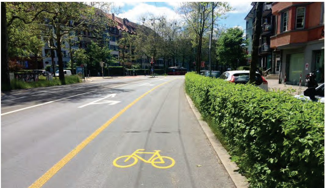
Abb. 21 Breiter Radstreifen (2.50 m breit) mit durchgezogener Linie auf der „Velohauptroute Wankdorf“ im städtischen Raum, Bern (CH)
