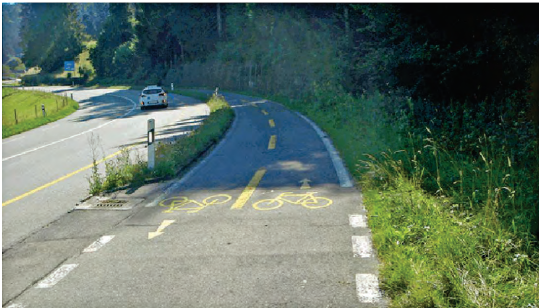
Abb. 55 Gezielter Einsatz von Markierung dort, wo notwendig, Beispiel Anlage Heimberg – Thun (CH)
