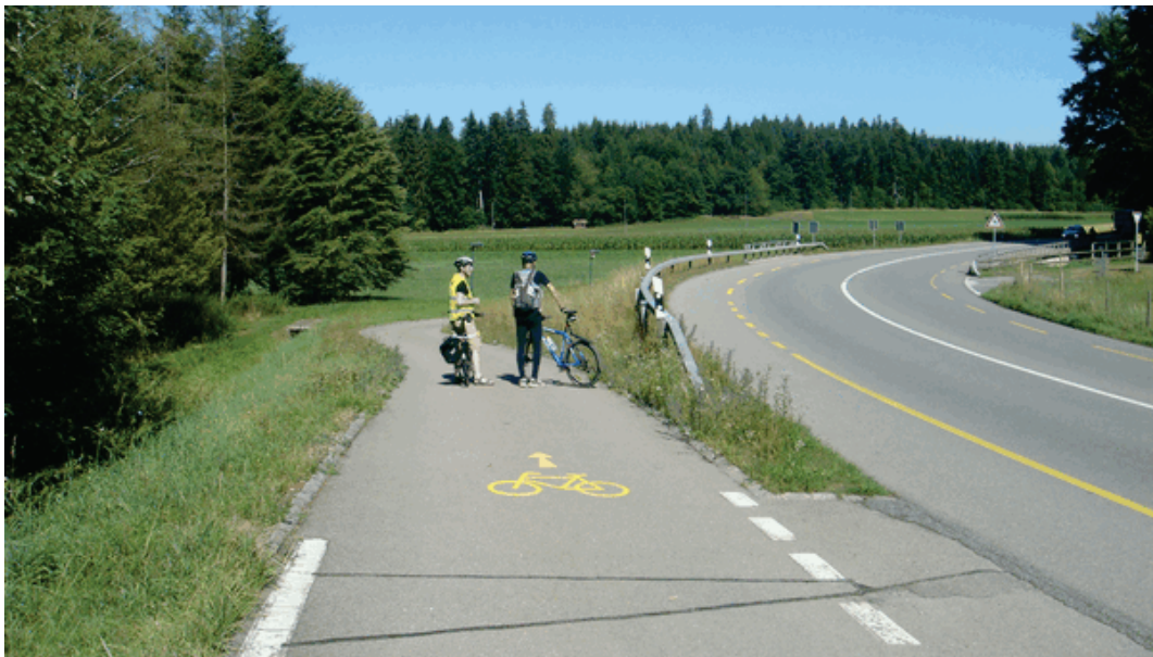
Abb. 58 Gezielter Einsatz eines eindeutigen, gut lesbaren Piktogramms auf der Anlage Thun-Heimberg (CH)
