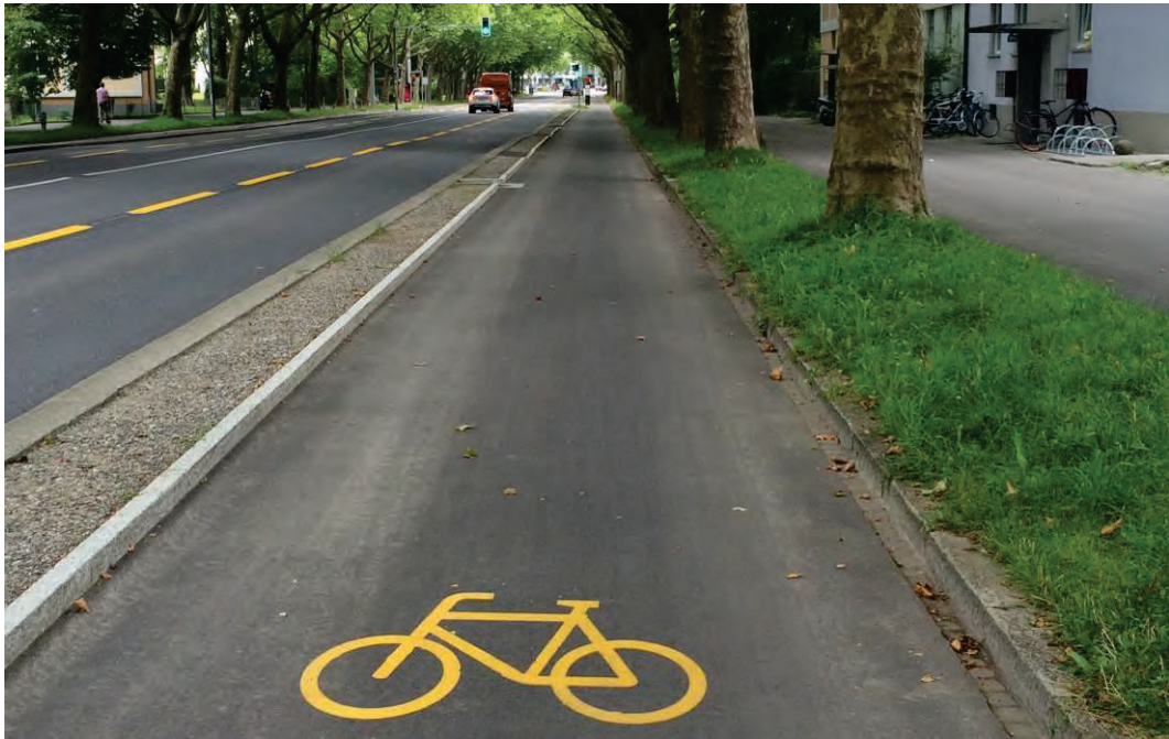
Abb. 18 Strassenbegleitender Richtungsweg (2.50 m breit) auf der „Velohauptroute Wankdorf“ im städtischen Raum Bern (CH)
