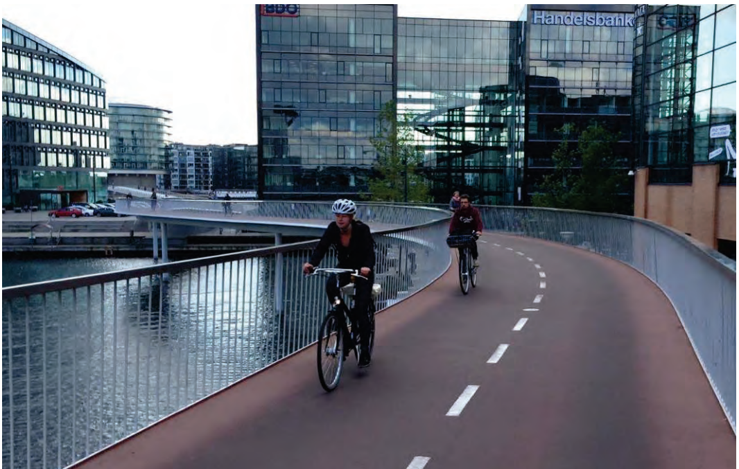
Abb. 13 Zweirichtungsradweg (4,25 m breit) auf einer Brücke auf der „Sø ruten“ im städtischen Raum in Kopenhagen (DK)
