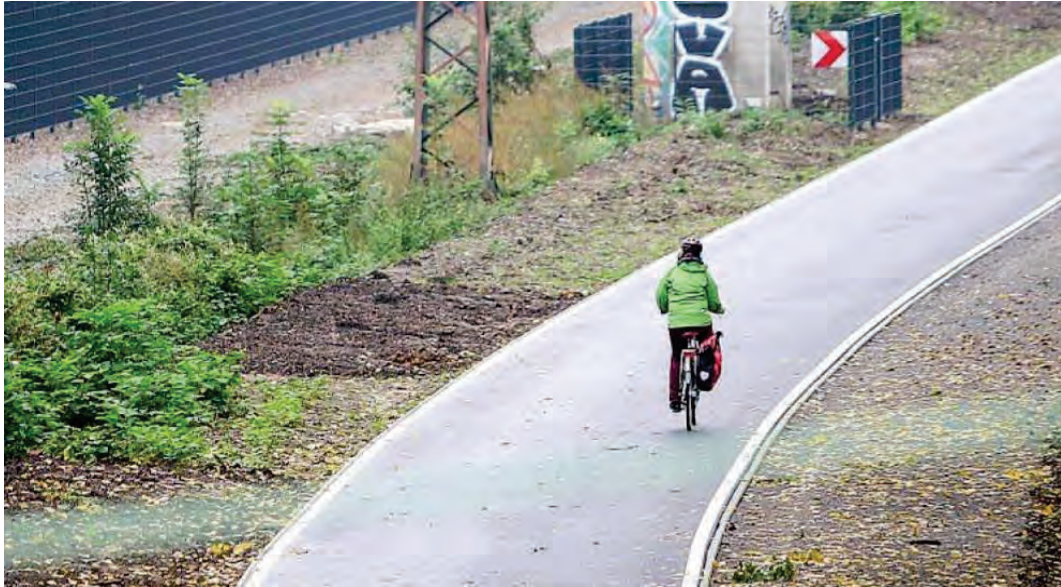
Abb. 33 RS1: 4 m breiter Zweirichtungsradweg auf dem RS 1 in Nordrhein Westfalen (D); Foto: Stephan Glagla, www.pott-media.de
