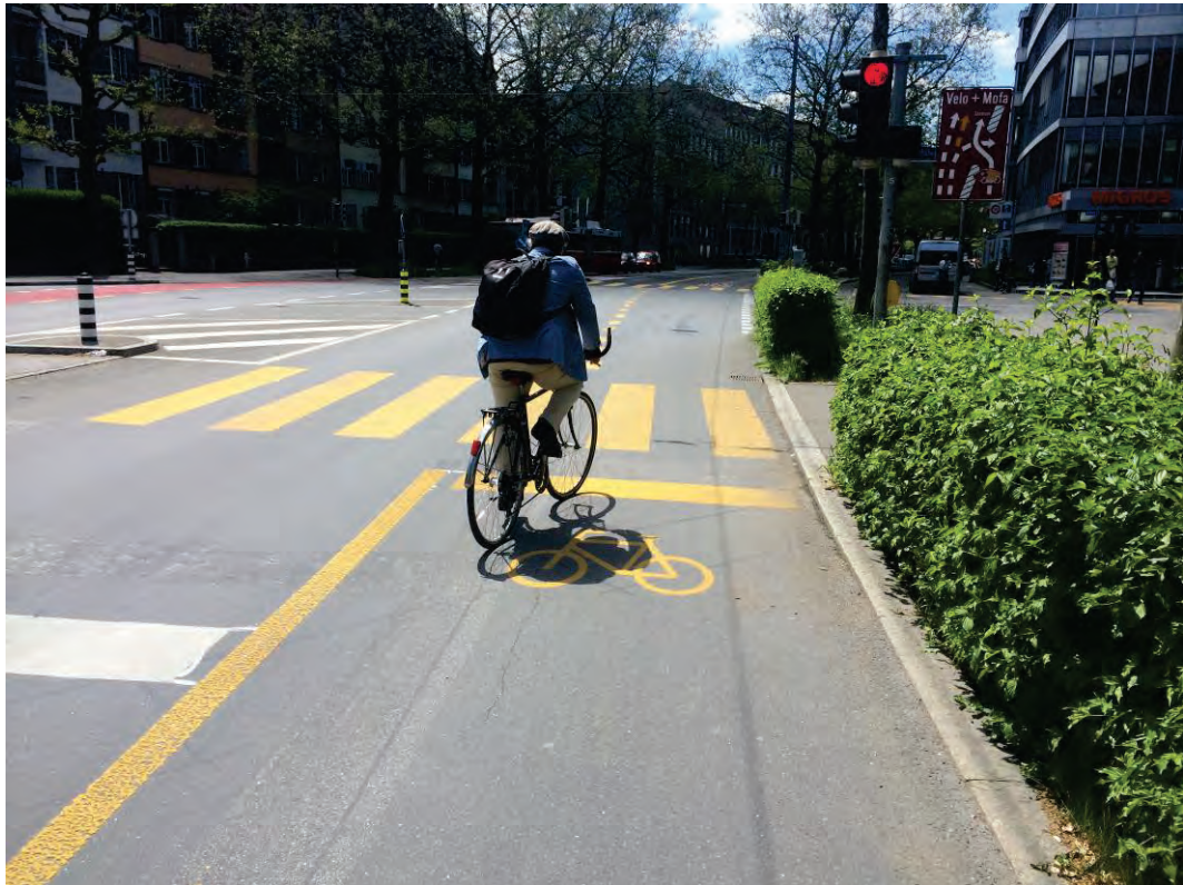
Abb. 51 Vorgezogener Haltebalken mit zuführendem breiten Radstreifen (ca. 2.5 m breit) auf der „Velohauptroute“ Wankdorf, Bern (CH)
