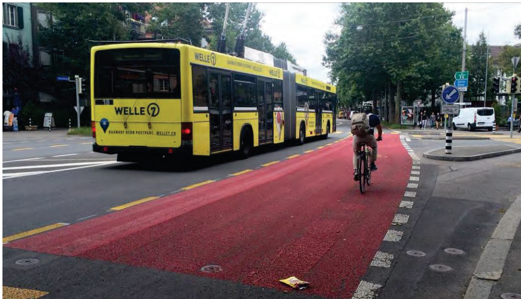
Abb. 56 Gezielter Einsatz von roter Farbe (Breite ca. 3.00 m) an einer Einmündung auf der „Velohauptroute“ Wankdorf, Bern (CH)
