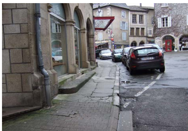
Des trottoirs de faible largeur, souvent dégradés
