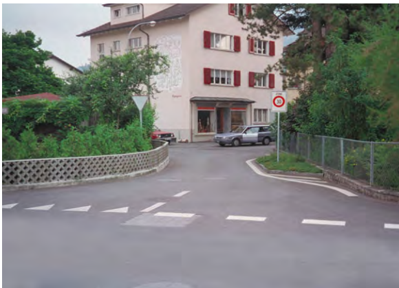
Abbildung 44 Torelement bei der Einfahrt in eine Tempo-30-Zone
