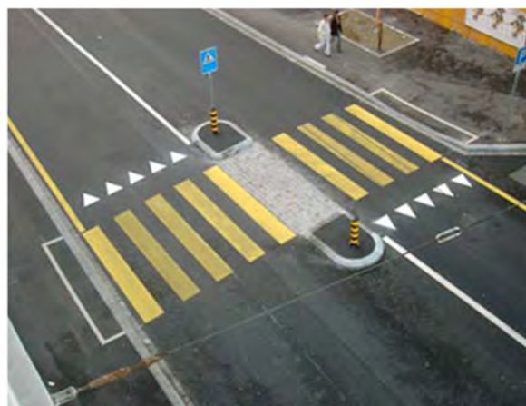
Abbildung 32 Wartelinie vor Fussgängerstreifen – Wirkung belegt
