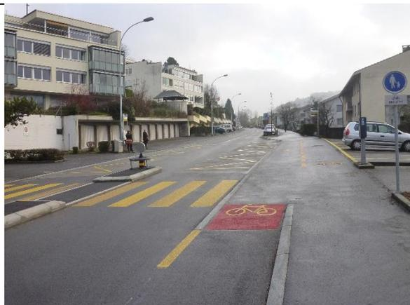
Stadtauswärts wurde ein Rad- und Gehweg für eine sichere Bergfahrt gebaut, gleichzeitig wurde die Strasse saniert. Das Trottoir wurde für den Rad- und Gehweg auf der gesamten Länge verbreitert.
