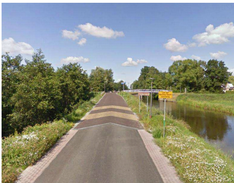
Stroobossertrekvaart après aménagement : le changement de revêtement annonce l'arrivée sur une intersection.
