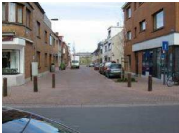
Même rue après aménagement : les dénivellations ont été supprimées
