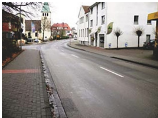
La Bremer Strasse à Bohmte, avant aménagement
