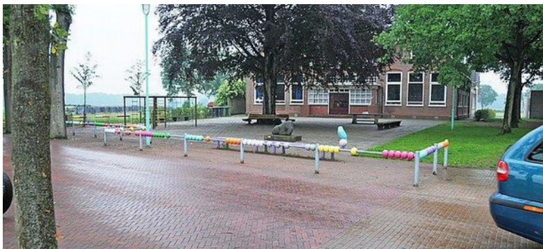
Entrée de ville de Haren après aménagement : la cour d'école empiète sur la chaussée
