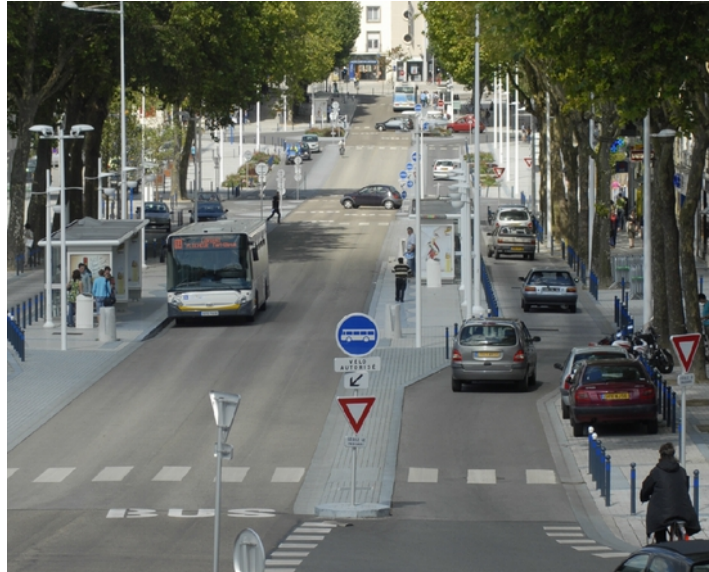
Avenue Anatole France à Lorient : cette large avenue située en zone 30 comprend deux larges espaces latéraux de plus de 8 m, deux voies de circulation tous véhicules (12 000 véhicules/jour et un couloir central bidirectionnel pour les bus (750 par jour) et les taxis, prioritaire sur tous les autres mouvements. Les cyclistes peuvent circuler partout.
