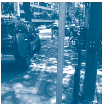
Separate Ladesäule (bereitgestellt von einer Krankenkasse)
