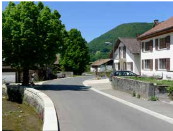
Diese Strasse im ländlichen Raum zeigt hohe Umfeldqualität.
