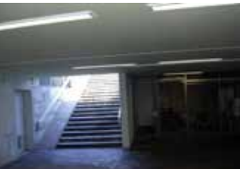
Schlechtes Beispiel: Unterführung mit nicht einsehbaren Nischen.
