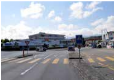
Der Fussgängerstreifen führt ungesichert über zwei Fahrstreifen in gleicher Fahrtrichtung.
