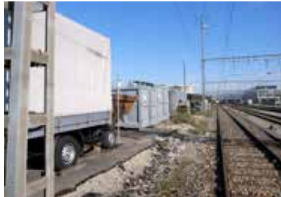
Eine Fusswegverbindung entlang der Geleise fehlt.
