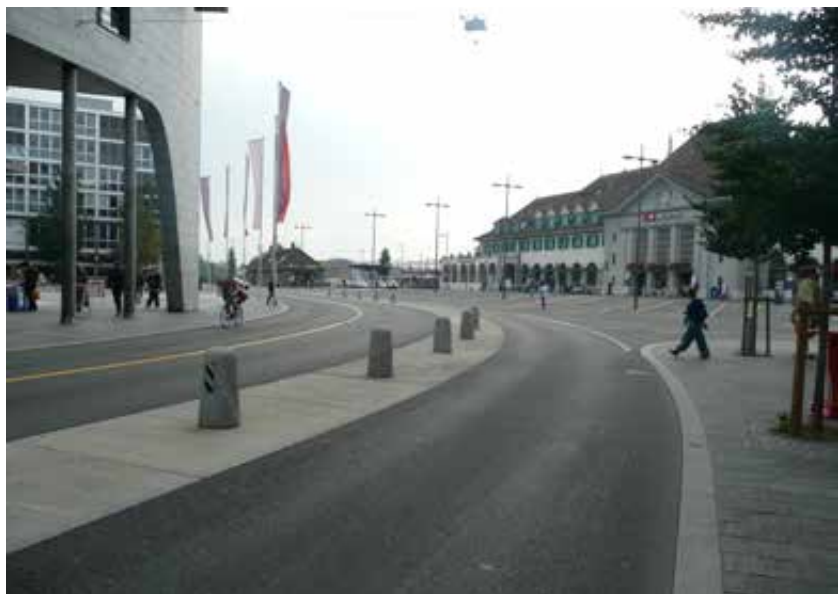
Eine flächige Querung ist möglich dank dem Mehrzweckstreifen in der Fahrbahnmitte.
