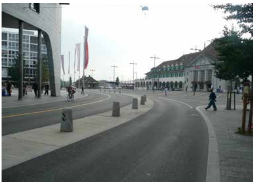
La traversée libre est rendue possible grâce à la bande polyvalente au milieu de la chaussée
