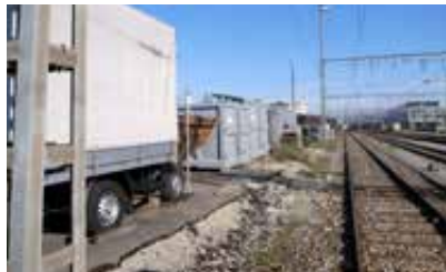
Il manque une liaison piétonne le long de la voie ferrée.
