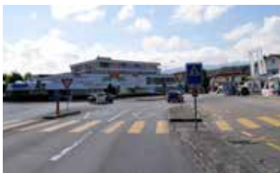
Le passage piéton n'est pas sécurisé alors qu'il traverse deux voies de circulation allant dans le même sens.
