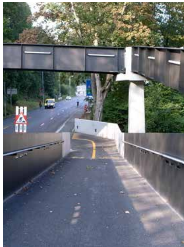
Ces passages inférieurs et supérieurs pour piétons et cyclistes, situés en localité, sont aménagés de manière confortable.
