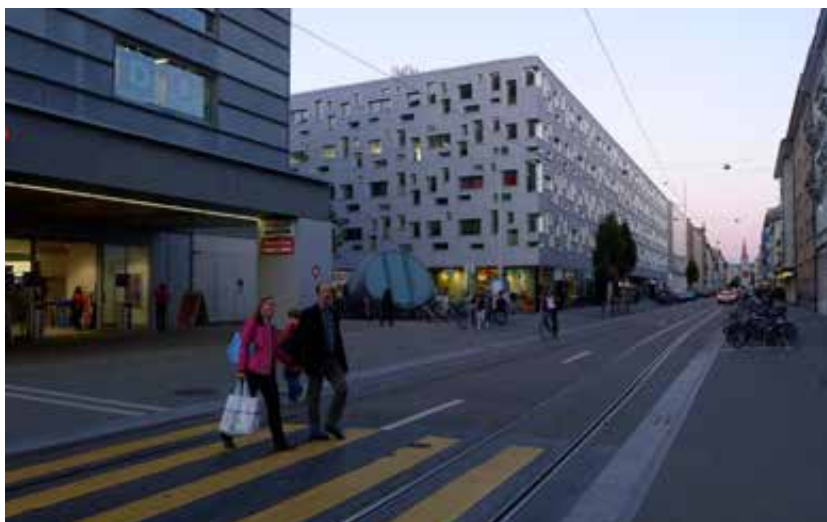
Une rue bien réaménagée, attractive pour les piétons
