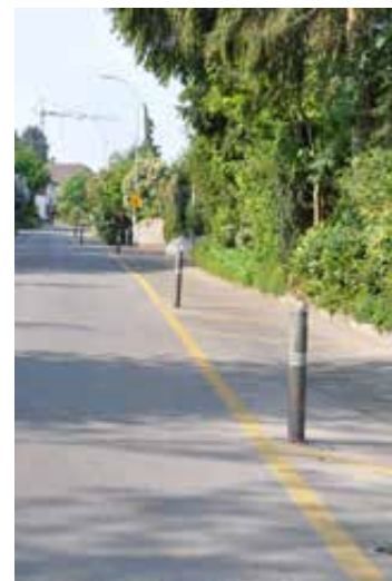
Bande longitudinale sécurisée à l'aide d'un poteau
