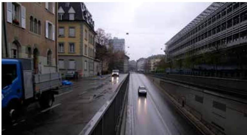
Effet de coupure dû à la présence d'éléments constructifs
