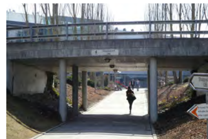
Shopyland Schönbühl (BE) Eine angenehme Allee führt direkt von der S-Bahn-Haltestelle zum Zentrumsseingang.
