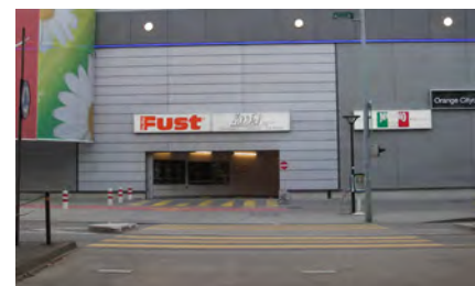
Es braucht eine bewusste Planung für fussgängerfreundliche Infrastrukturen und die entsprechenden Fachkompetenzen, um unbefriedigende Situationen wie diese zu vermeiden.
