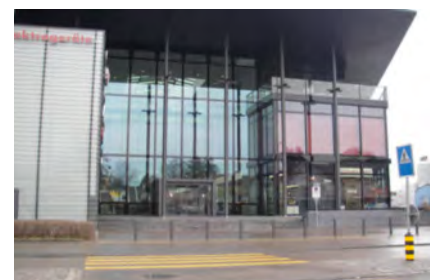
Dietlikon Industrie (ZH) Gepflegtes Design des Eingangs, der eine Verbindung zur Strasse schafft.
