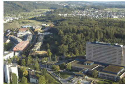
Hôpital cantonal de Baden-Dättwil (AG) Cette échelle de localité est propice aux déplacements à pied et à vélo, un atout à exploiter pour l'accessibilité des équipements.
