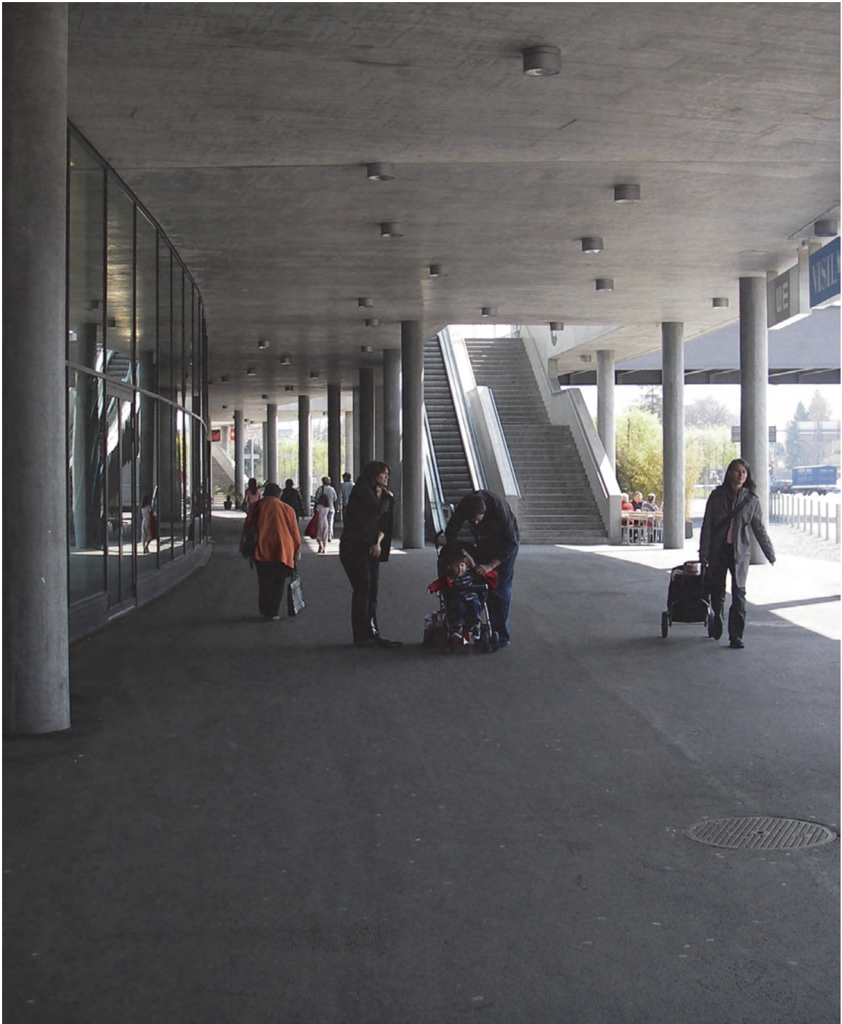
Galerie d'accès Shopping Arena, sous le stade (SG)
