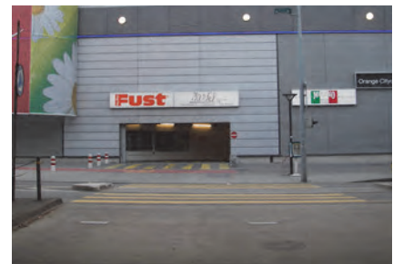
La planification des aménagements piétons requiert une attention à la problématique et des compétences professionnelles fines, pour éviter notamment ce type d'exemple...
