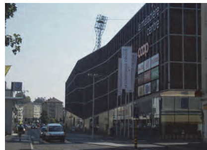
Centre de la Maladière (NE), exemple d'implantation bien intégrée, par l'organisation des éléments du programme et le traitement des espaces extérieurs.
