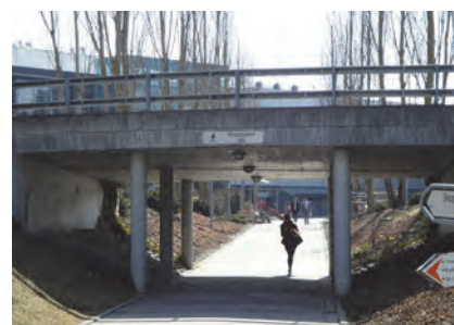
Shoppyland Schönbühl (BE) Une allée d'accès agréable et directe entre halte du RER et entrée.
