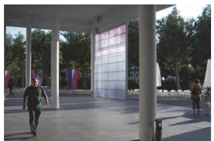
Large et agréable couvert marquant l'entrée principale du Stücki Shopping Center (BS)
