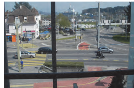
CineMAXX Emmen (LU) Il est prévu de réaménager le carrefour à caractère très routier sur lequel donne le bâtiment.
