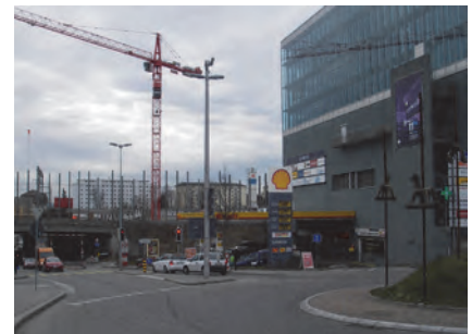
Malley Lumières, Prilly (VD) Situé dans un secteur en plein développement, le centre se trouve aujourd'hui au cœur d'une nouvelle interface de transport public : halte de RER, arrêts de bus, métro à 5 mn.
