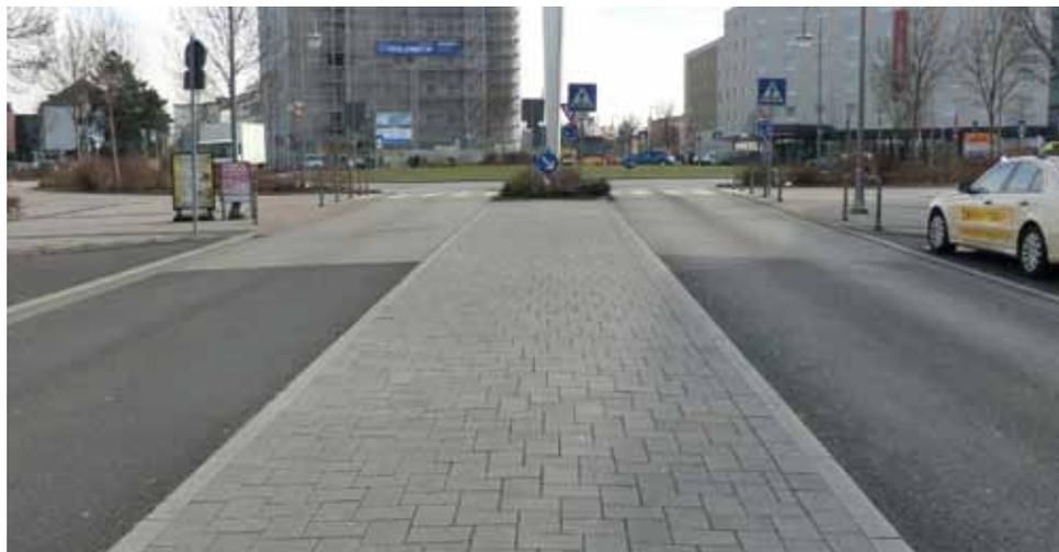
Abb. 6 In Hanau ermöglicht der Mittelstreifen der Nürnberger Straße das Queren der Fahrbahn auf der ganzen Länge
