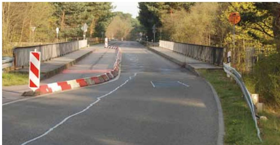
Abb. 24 Schmale Brücke mit Sonderbereich für Fuß- und Radverkehr bei Pfungstadt
