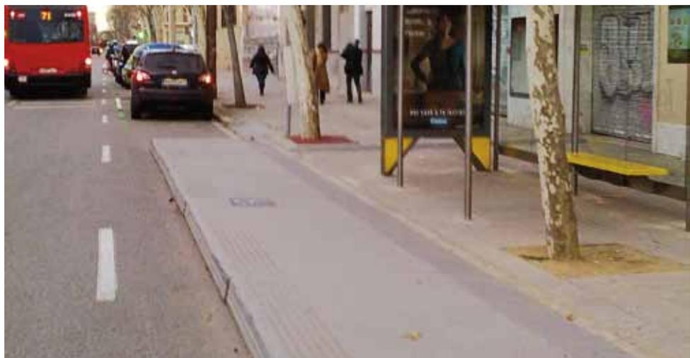
Abb. 41 Fertig-Element zur Herstellung von barrierefreien Bushaltestellen in Barcelona
