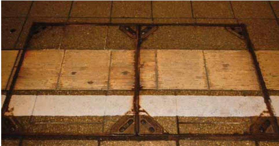
Ausmauerbarer Schachtdeckel mit integrierbarem Leitsystem in Freiburg Abb. 38
