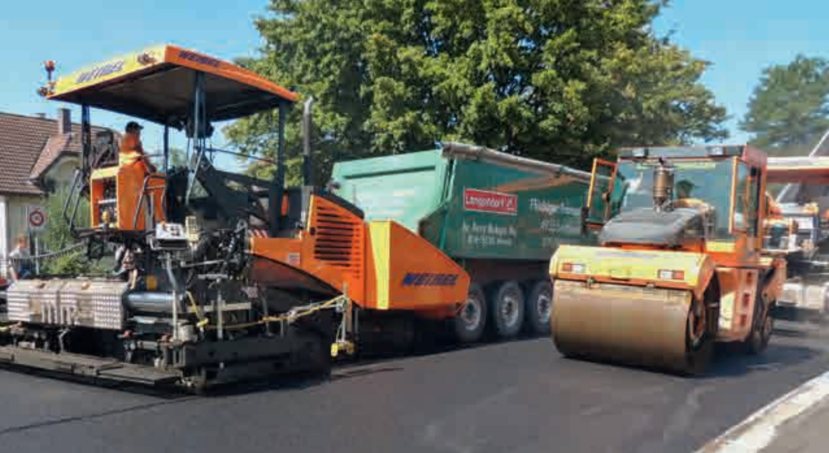
Les revêtements routiers silencieux peuvent réduire de plus de moitié le bruit du trafic.
