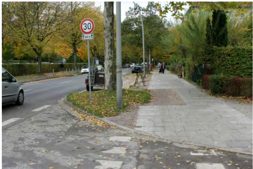
Abb. 40: Alter Teichweg auf der neuen Ist-Route stadteinwärts: für Rad- und Gehweg ist nicht viel Platz, die Bäume behindern eine sinnvolle Neuverteilung der Fläche.
