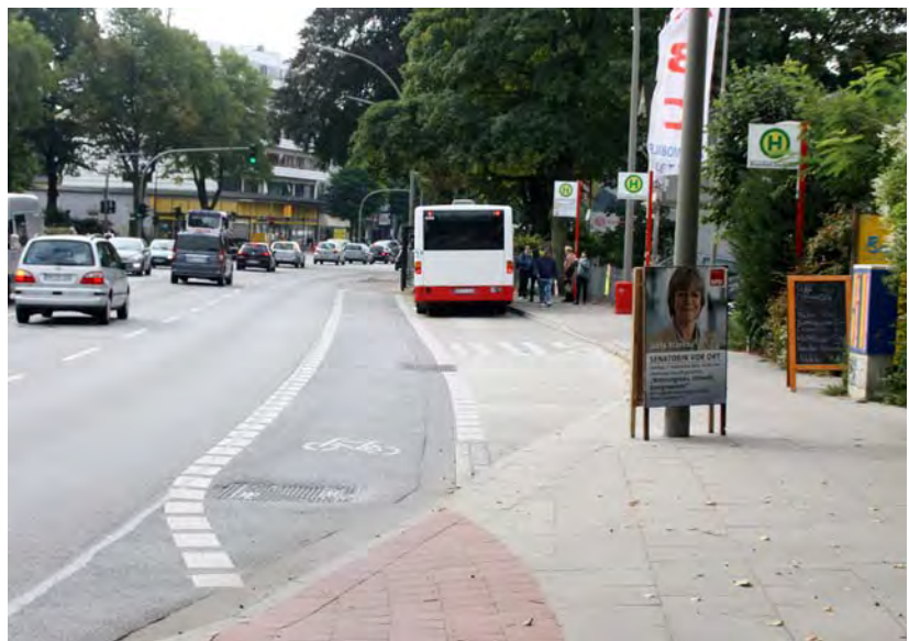
Abb. 36: Bramfelder Chaussee stadteinwärts: Der Radverkehr wird sicher und komfortabel um eine Engstelle an einer Bushaltestelle geführt. Die Bramfelder Chaussee ist die beste Alternative zur umwegigen Routenführung quer durch Barmbek.
