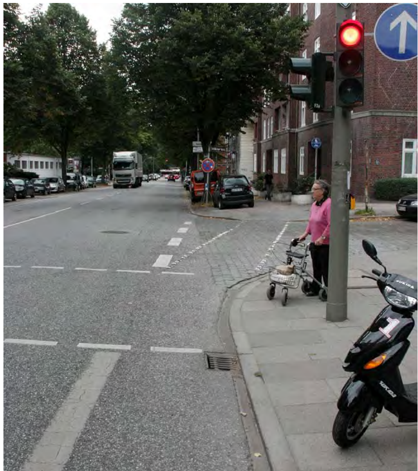
Abb. 45: Alternativroute zur Veloroute 6 im Dulsberg stadtinwärts: Stormaner Straße Ecke Lauenburger Straße endet der bequeme Radfahrstreifen und führt zur Verwirrung der von rechts kommenden Autofahrerinnen quer über das Kopfsteinpflaster auf einen engen Gehweg in schlechtem Zustand. Weil das Zeichen 240 nach StVO (gemeinsamer Fuß- und Radweg) noch nicht entfernt wurde, ist der Gehweg für Radfahrerinnen benutzungspflichtig. (Abb. 39 Nr. 6)
