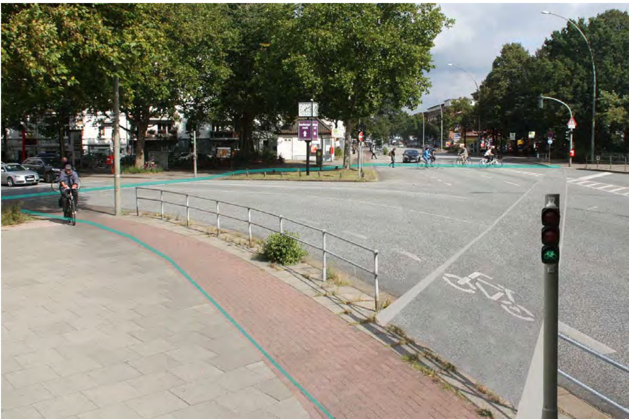
Abb. 49: Fotomontage der vorgeschlagenen Radfurt zur direkten Überquerung des Knoten Mundsburger Brücke. Türkis: bisherige, umwegige Führung der Veloroute 6 stadteinwärts mit doppelter Wartezeit durch zwei getrennte LSA.
