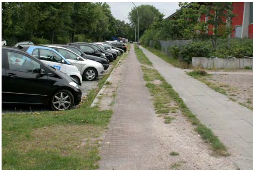
Abb. 41: Im Eulenkamp auf der Alternativroute ist gegenwärtig ein schmaler Radweg in schlechtem Zustand, aber viel Fläche für den konfliktfreien Bau eines hochwertigen Radwegs vorhanden.
