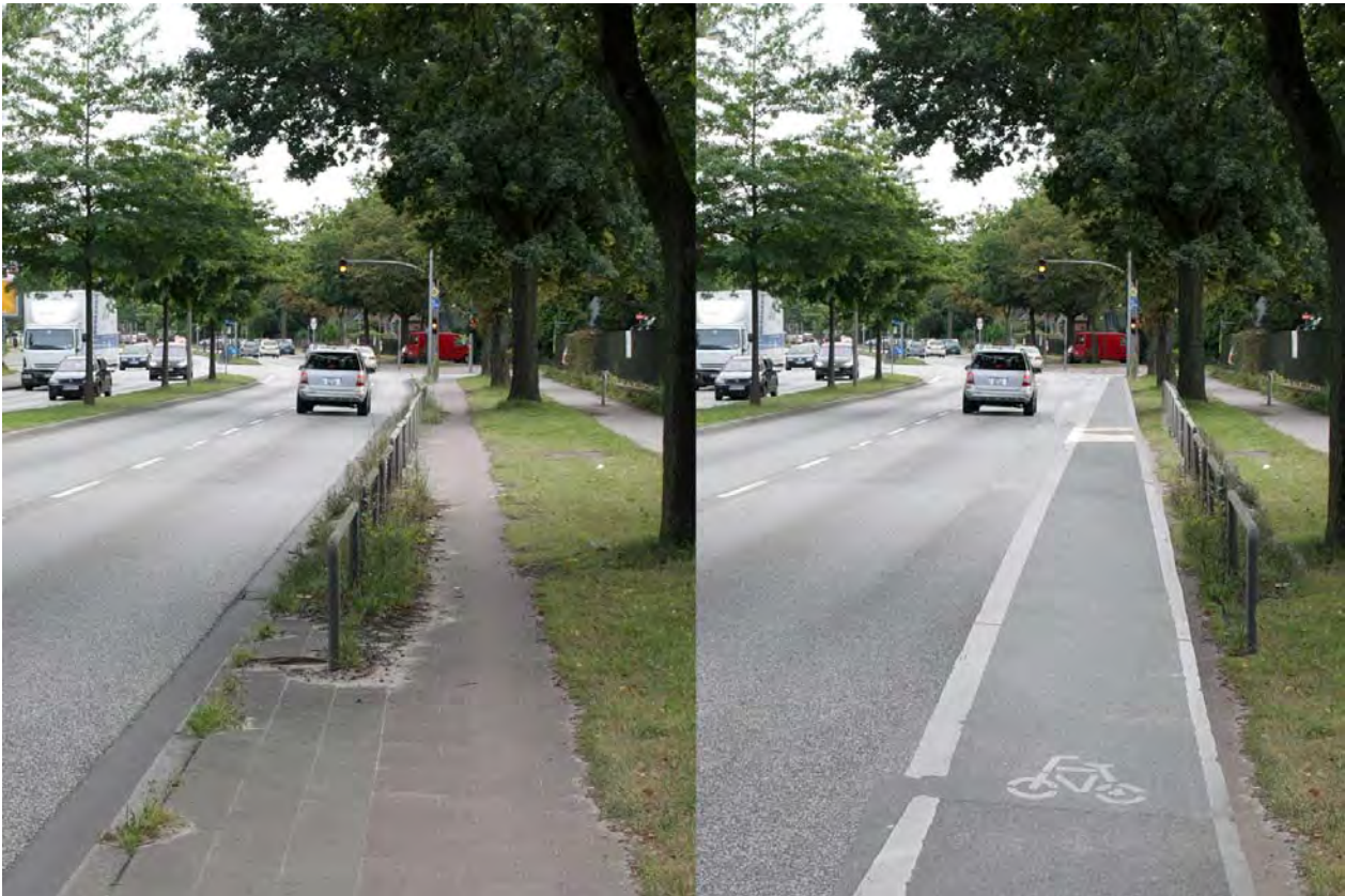
Abb. 24: Der Radweg im nördlichen Teil der Sengelmanstraße stadteinwärts rechts ist sehr schmal (links). Wird die Bordsteinkante versetzt, bleibt genug Platz für einen Radfahrstreifen (Fotomontage rechts).
