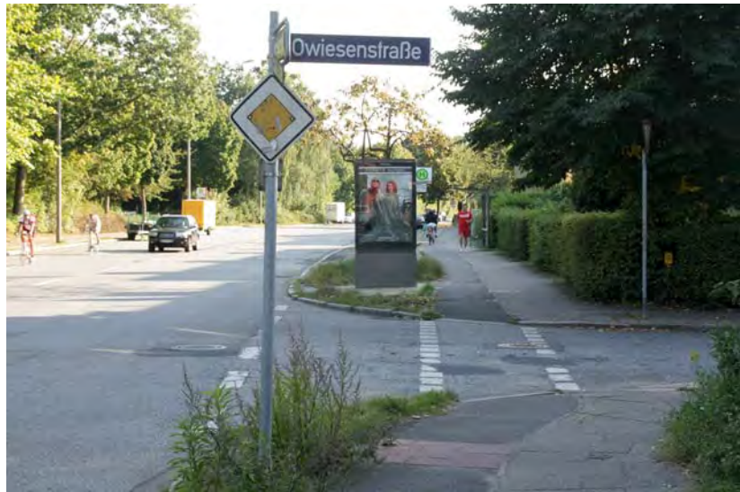
Abb. 37: Fabriciusstraße in Hinrichtung: rechts geht die Ist-Route Richtung Appelhoffweiher weiter, geradeaus wird Alternativroute 2 fortgesetzt. Der Radweg ist schmal und sehr schlechtem Zustand. An der Bushaltestelle Owiesenstraße (Bildmitte) ist ein Engpass. Links im Bild: Radfahrer meiden die beschädigten (nicht benutzungspflichtigen) Radwege und nutzen die Fahrbahn. Bildmitte: die wenigsten Radfahrerinnen trauen sich auf die Fahrbahn, wenn ein Radweg zu erkennen ist.
