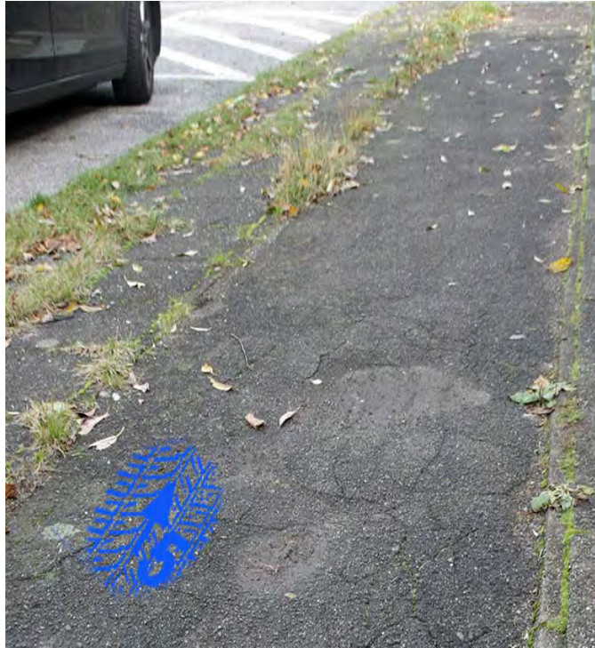
Abb. 57: Aufgesprayte Veloroutenmarkierungen sind günstig und schnell und zu realisieren – bevor irgendwann eine richtige Farbmarkierung kommt.
