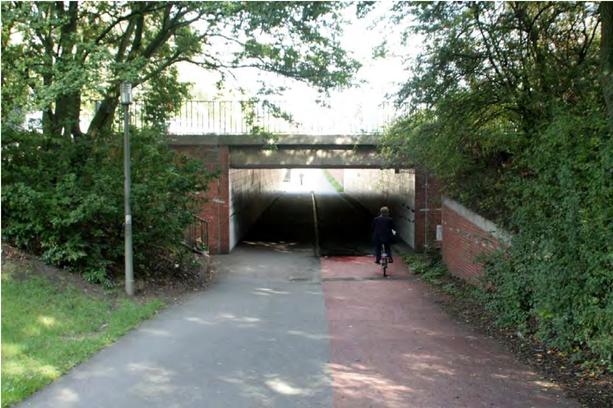
Abb. 54: Unterführung parallel zur Barcastraße unter der Sechslingspforte auf der Alternativroute (verortet in Abb. 50, Nr. 2).
