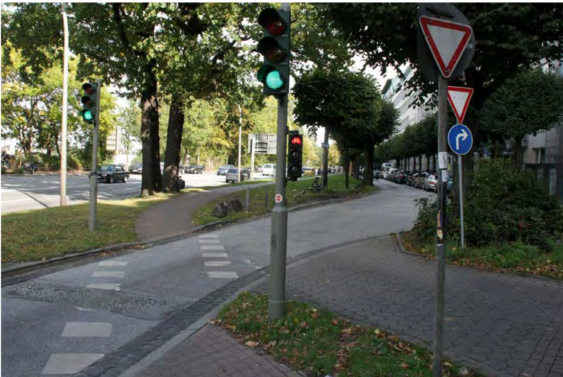
Abb. 51: Alternativroute an der Alster: der Radverkehr soll hier an der Ampel warten, bevor er auf dem nichtbenutzungspflichtigen Radweg parallel zur breiten Nebenstraße weitergeführt wird.
