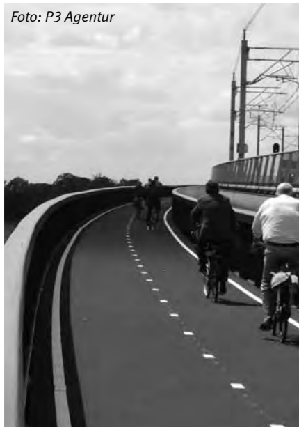
Fahrradbrücke entlang einer Eisenbahnlinie in Zwolle
