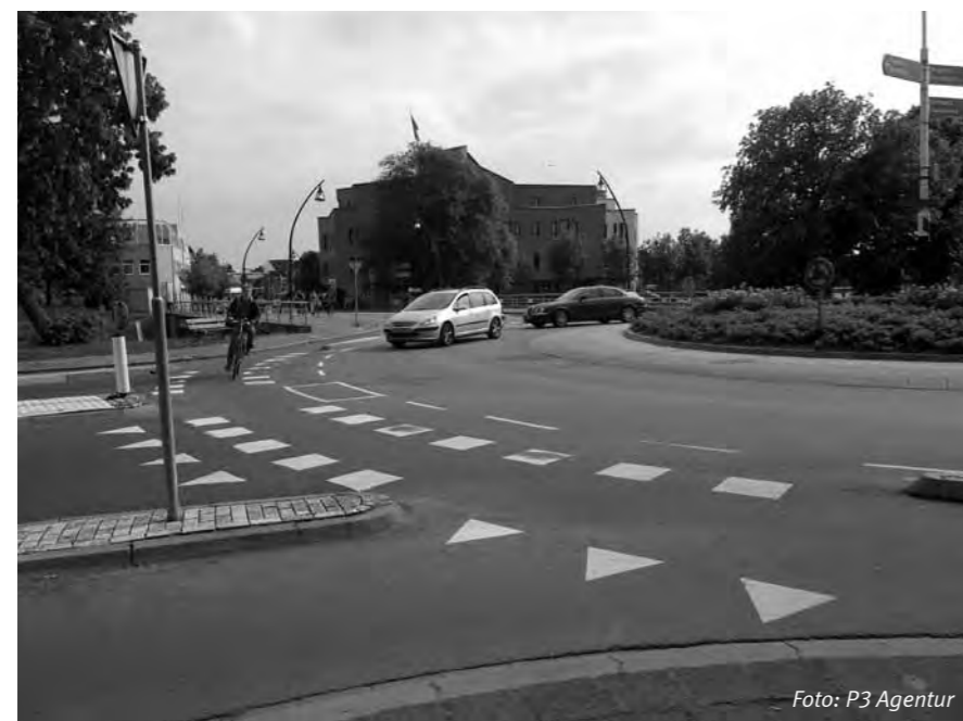
Zentral gelegener Kreisverkehr mit fahrbahnseitiger Radverkehrsführung
