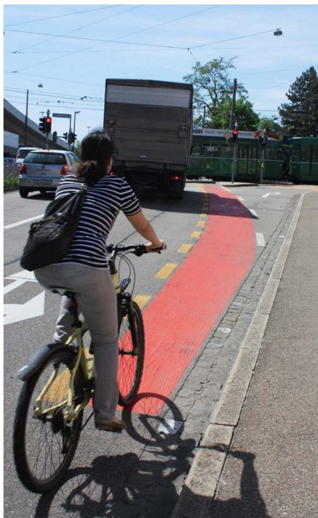
St. Jakobs-Strasse, rot eingefärbter Radstreifen nach Abfahrt von Radweg im Knotenbereich mit separater Rechtsabbiegespur
