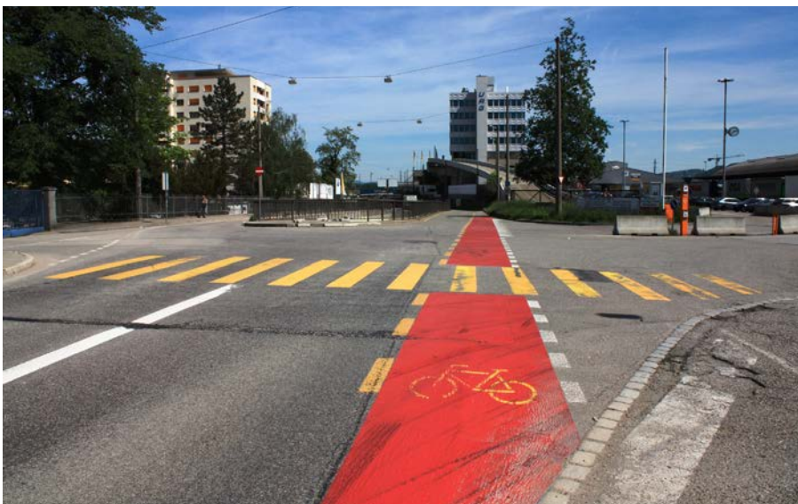
Gefahrenstelle schleifende Querung des Radstreifens durch ausfahrende LKW zu Güterbahnhof
