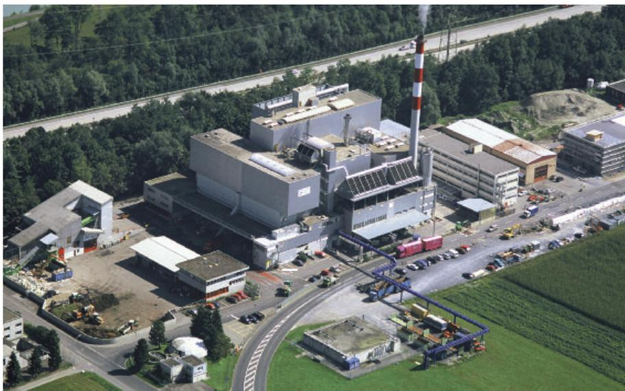
In der Kehrichtverbrennungsanlage (KVA) Buchs werden Hauskehricht, Industrie- und weitere Abfälle verwertet. Die daraus gewonnene Verbrennungswärme wird für die Erzeugung von Strom und Fernwärme genutzt. Den Strom verkauft die KVA Buchs der St. Gallisch-Appenzellischen Kraftwerke AG (SAK). An das stetig wachsende Fernwärmenetz sind grosse Industrie- und Gewerbebetriebe, Schulanlagen und andere öffentliche Gebäude sowie zahlreiche Wohnquartiere der Gemeinde angeschlossen.
