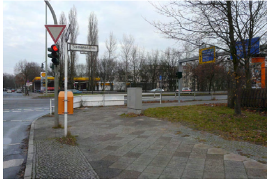
Die Plateaupflasterungen waren als Querungsanlage für Fußgänger gedacht. (GHHW Nr. 18-054)
