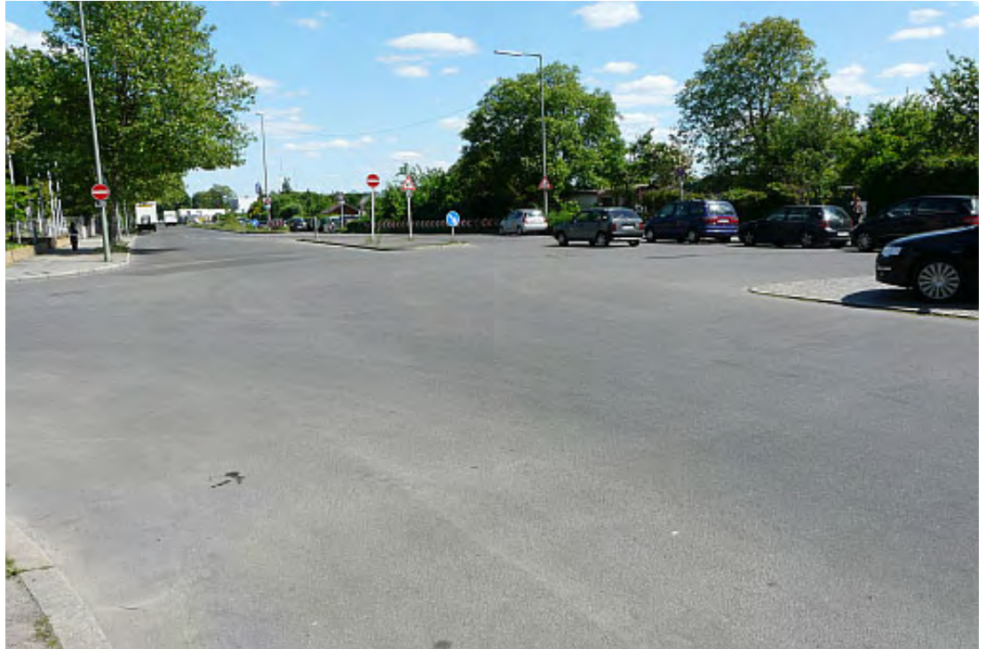
Querungsstelle über die Fahrstreifen nur einer Fahrtrichtung der Ullsteinstraße in Tempelhof-Schöneberg. Die Straße ist trotz der Verkehrsbelastung von etwa 13.000 Kraftfahrzeugen pro Tag (DTV) und trotz des hohen Lkw-Anteiles überdimensioniert und sollte rückgebaut werden (QSt 10-002).
