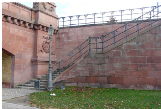
Es ergibt schon einen Unterschied, ob ein barrierefreier Zugang an einem historischen Bauwerk wie hier an der Molkebrücke ... (GHW Nr. 19-097)
