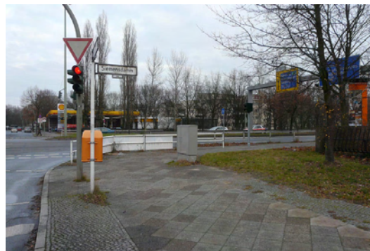
Eine für Berlin recht typische Situation: Die direkte Querung ist am Siemensdamm in Charlottenburg-Wilmersdorf an der Lichtsignalanlage nicht möglich. Die Fußgänger wären dem Abbiegeverkehr im Wege, also müssen sie 14 Fahrstreifen überqueren und dabei vier Grün-Zeiten abwarten. (GHW Nr. 18-085)
