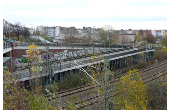
Die Rampe zur Unterquerung Behmstraße ist überaus komfortabel ausgefallen. (GHW Nr. 18-051)
