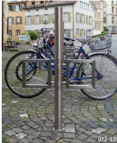
Arceaux, ici sous forme de poteaux
