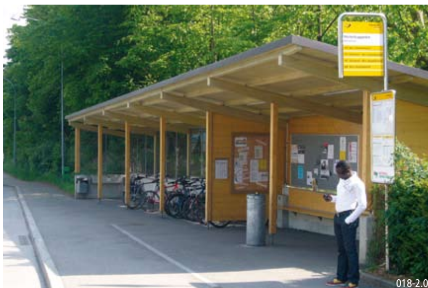
Places couvertes pour vélos à un arrêt de bus
