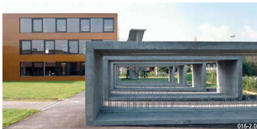
Places de stationnement pour vélos visibles depuis les salles de classe
