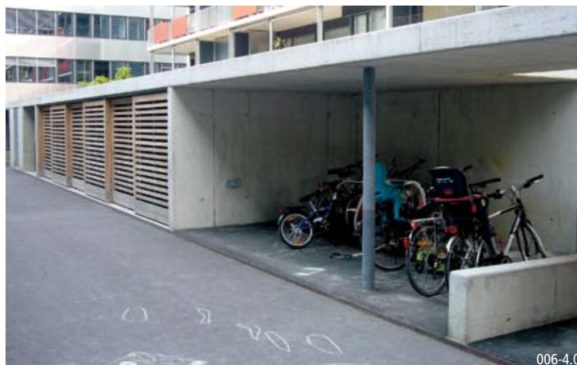
Installation verrouillable (à gauche) combinée avec une installation ouverte
