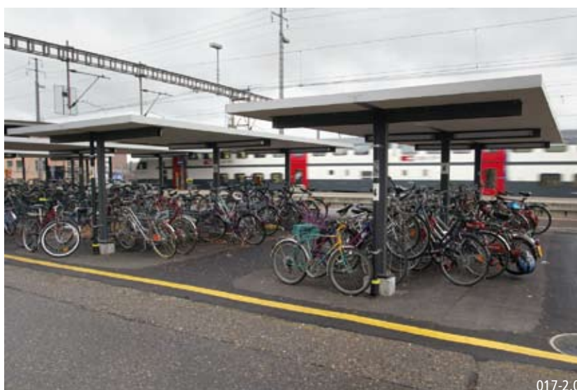
A proximité des quais, installation couverte et éclairée
