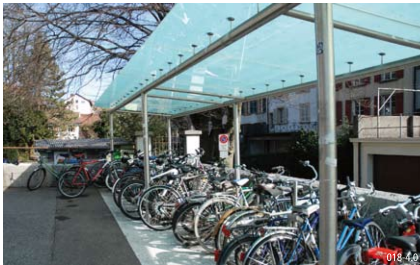
Toiture isolée sans parois latérales
