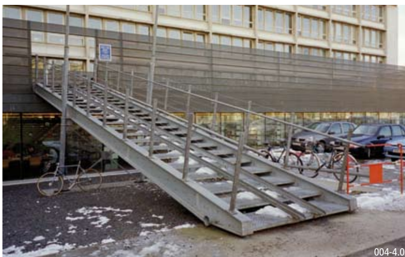
Escalier avec des glissières de guidage
