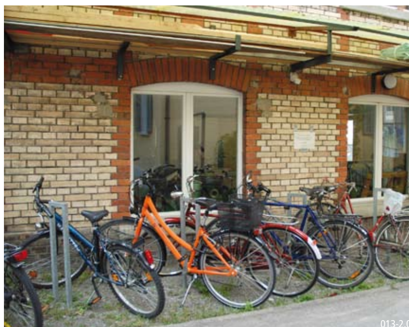
Stationnement couvert pour les vélos d'une petite entreprise
