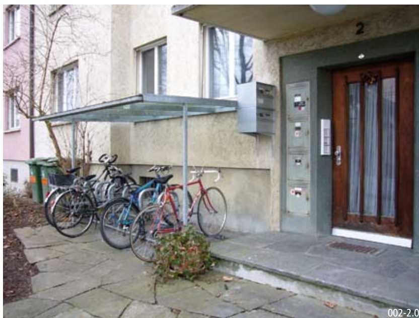
Proche de l'entrée, cadre attachable, toiture
