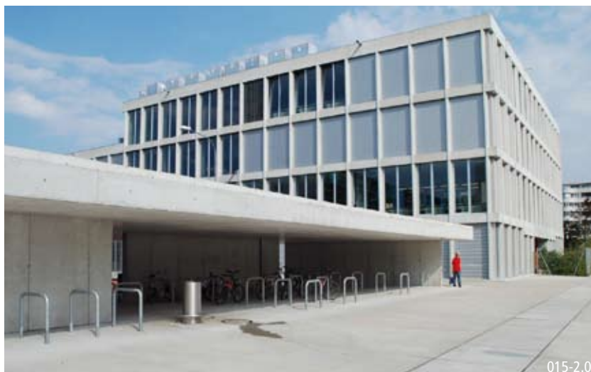
Stationnement pour vélos d'une école secondaire
