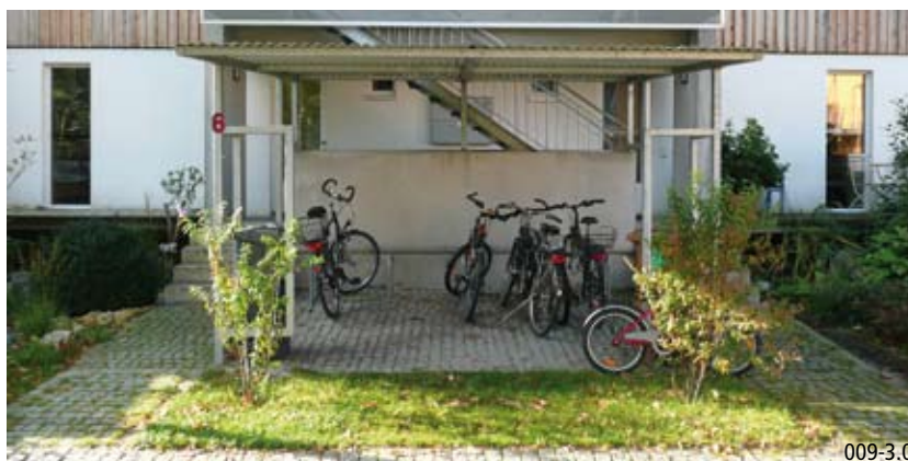
Parkings pour vélos intégrés lors d'une réhabilitation complète
