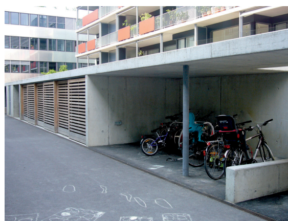
Installation verrouillable (à gauche) combinée avec une installation ouverte
