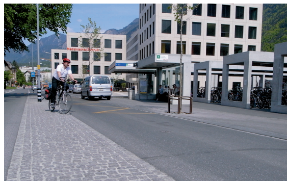
Aide au changement de direction au milieu de la chaussée et trottoir à bord plat pour faciliter l'accès
