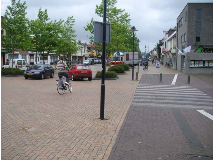
Bild 5: Knotenpunktzufahrt Noordkade/Zuidkade mit Baumscheiben zur Kanalisierung, Drachten, Niederlande
