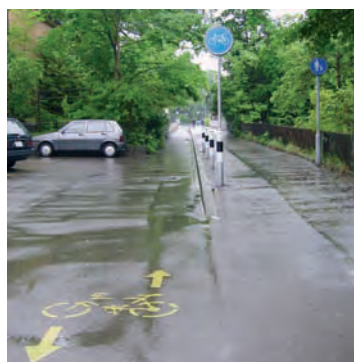
Zürich, Birchsteg: Getrennter Fuss- und Radweg. Das Regime wird baulich (Absatz zwischen den beiden Bereichen) sowie mittels Signalisation und Markierung verdeutlicht.
