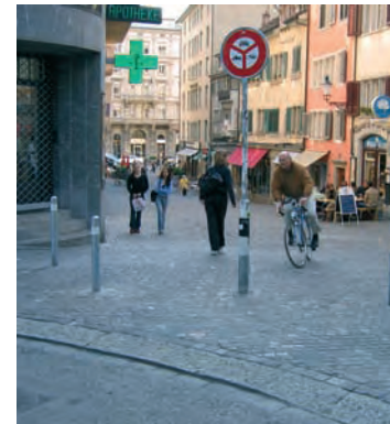
Zürich, Torgasse (Blick von der Oberdorfstrasse): Deutliche Abgrenzung von Fahrbahn (im Bild unten links) und Fussgängerbereich. Die Anrampung, die Pfosten und der Belag führen zu einer langsameren Fahrweise der Velofahrenden. Die Pfosten verhindern die Durchfahrt für die Autos.
