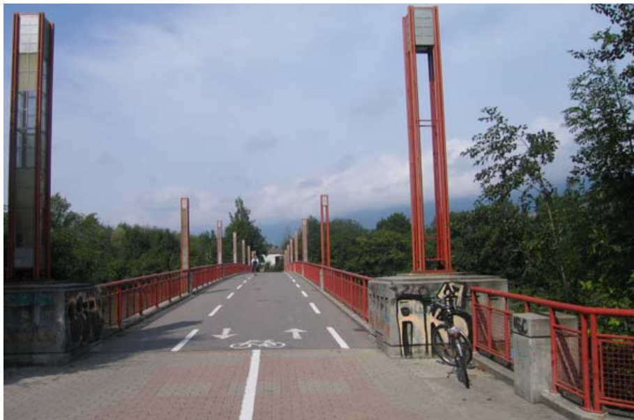
Blick aus Osten auf die Fussgänger- und Velobrücke Schützenmatt
