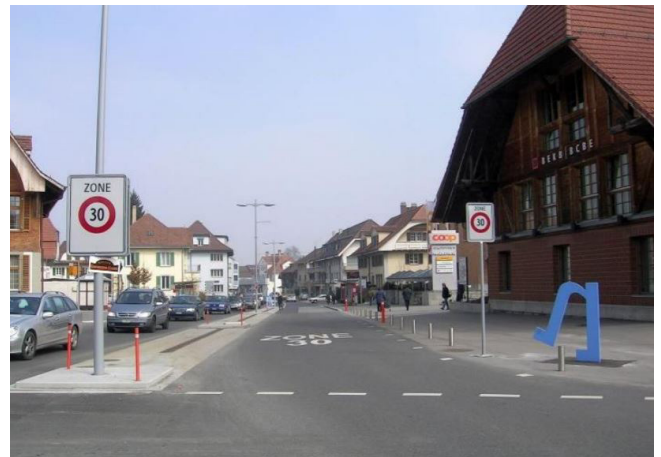
Fig. 3 : Entrée de la zone limitée à 30 km/h sur la Schwarzenburgstrasse à Köniz (BE)
