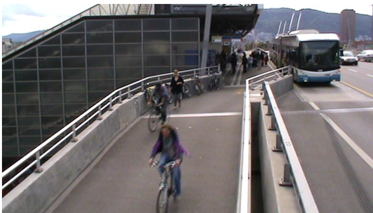
Abb. 43 Zürich, Hardbrücke "Rampe"
