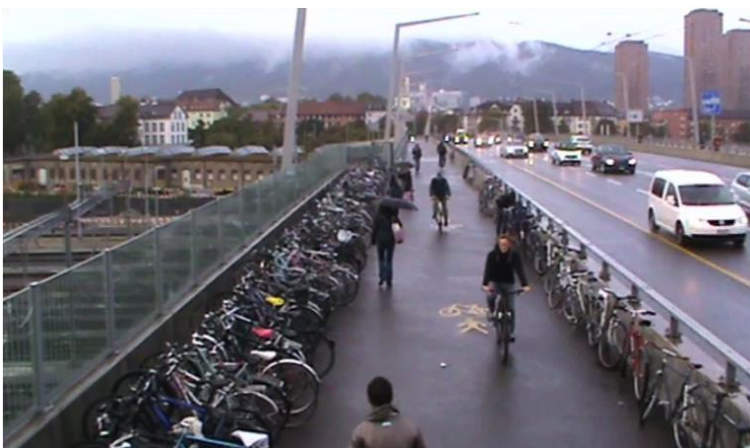
Abb. 42 Zürich, Hardbrücke „freie Strecke“
